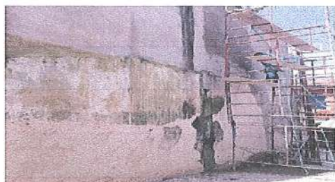
Foto1: Repello de muro frontal
