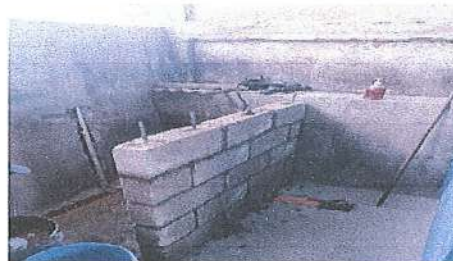
Foto 6: construcción de pared perimetral para sanitarios
