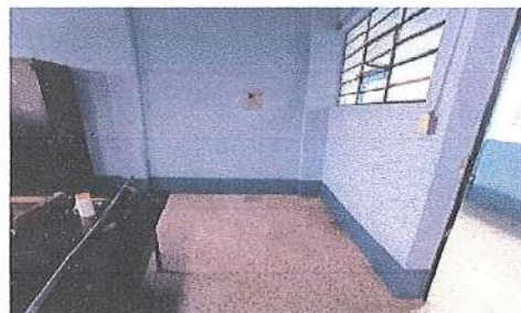
Foto 4: aplicación de pintura de zocalo
