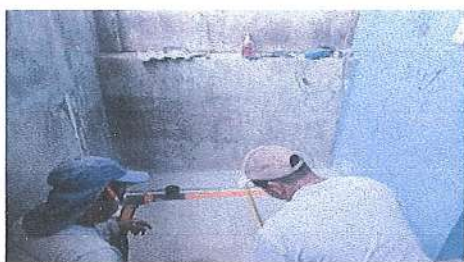
Foto 5: colocación de tubería para drenaje de sanitario
