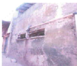
Foto 3: Sustitución de vidrios
