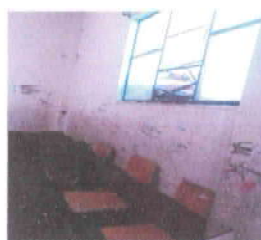
Foto 4: Pintura en muros interiores
