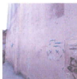
Foto 5: Pintura en muros exteriores
