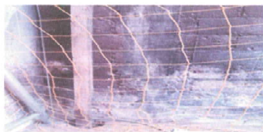
Foto 10: Sellado de grietas y fisuras en muros mantenimiento de reposadera
