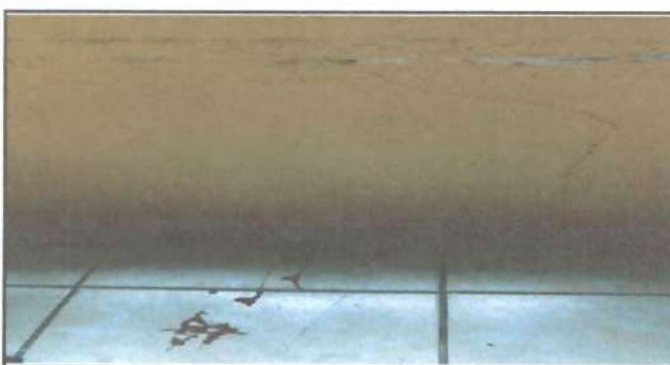
Foto 5: sustitución piso de cerámico en salones de clases
