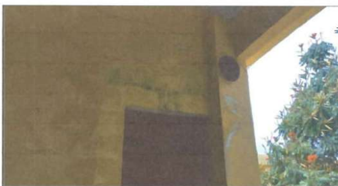
Foto 3: Mantenimiento bajadas de agua en pared de tabla yeso
