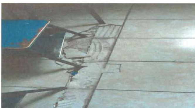
Foto 4: sustitución de piso de torta en salón de clases
