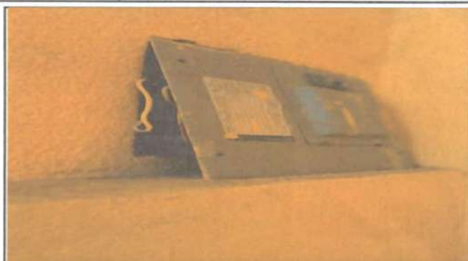
Foto 2: Mantenimiento de cajas de electricidad
