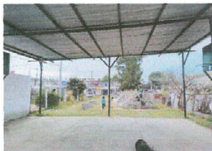
Foto1: Sustitucion de galera de lamina por galera de lamina con mayor soporte
