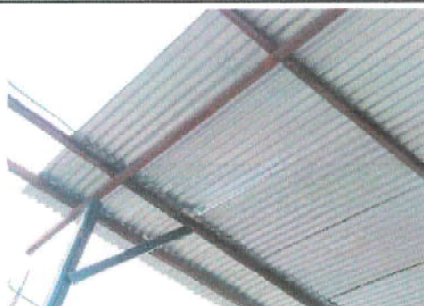
Foto 3: Mejoramiento de soporte de costaneras
