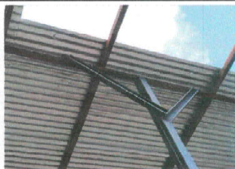
Foto 2: Sustitución de lamina
