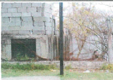
Sustitucion de malla por lamina troquela calibre 26
