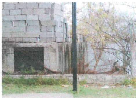
Foto 4: sustitucion de columnas por columnas de metal
