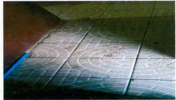
Foto 4: en esta area se va emplazar el piso de la cocina por ceramico
