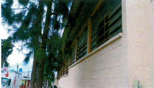
Foto1: en esta ventana es donde se van a colocar los balcones
