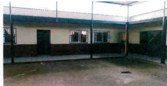
Foto 6: se tiene contemplado repellar el zocalo del area exterior de las aulas, ya que se descascara la pintura
