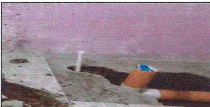
Foto 11: Suministro e instalación de tubería PVC DE 3" para drenaje de inodoros.
