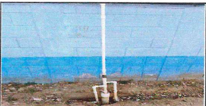
Foto 27: Sustitución de bomba de agua de 1HP (incluye conexión hacia instalación eléctrica y protección de bomba).
