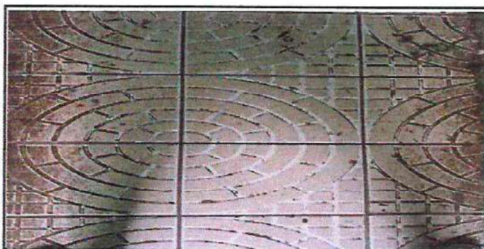
Foto 23: Sustitución de piso cerámico, baños niños.
