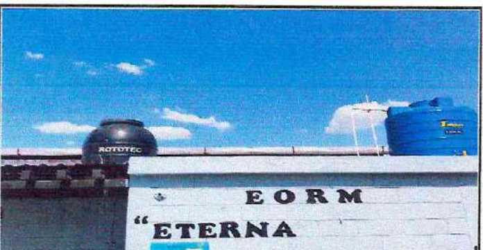
Foto 29: Reparación y mantenimiento de tinacos existentes (incluye reparación y sustitución de tubería de agua potables, aacesorios y llaves).
