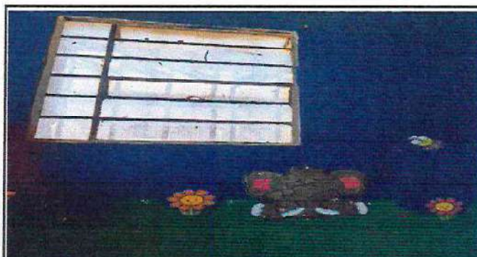
Foto 26: Sustitución de ventana por ventana de pvc en aula (incluye ampliación y tallado ) 1.60 x 2.10 mts.
