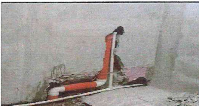
Foto 12: Suministro e instalación de tubería PVC de 2" para drenaje de lavamanos.
