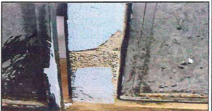
Foto 18: Sustitución de azulejos, baños niños.
