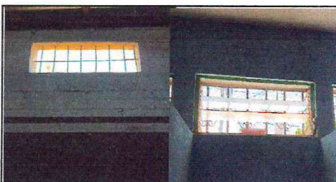
Foto 22: Mantenimiento de estructura de metal de ventanas (4 sifones, 3 cedazos para sanitarios)
