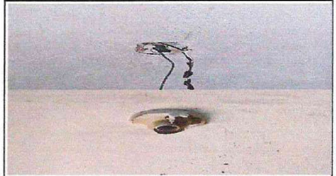
Foto 14: Sustitución de lámparas (incluye sustitución de cableado eléctrico e instalación de canaleta).
