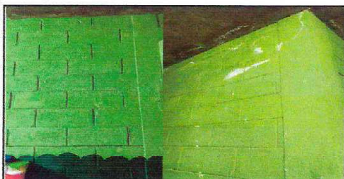
Foto 3: Suministro y aplicación de repello y cernido de paredes interiores cocina.
