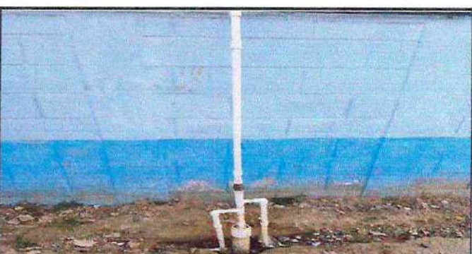
Foto 30: Instalación de estructura portante de metal (para cubrir bomba).
