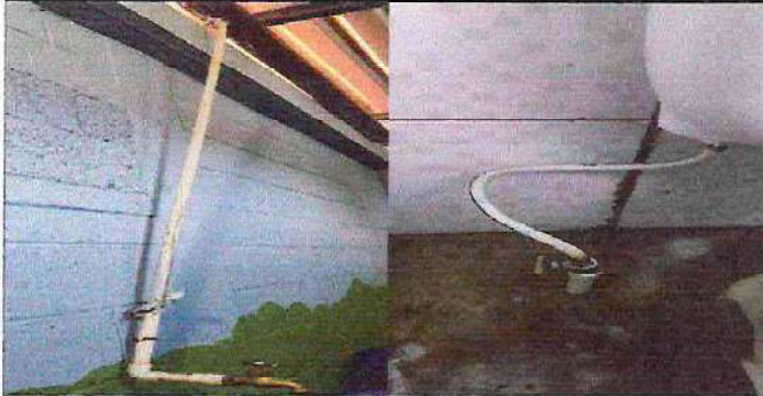
Foto 13: Suministro e instalación de tubería PVC de 1/2 para agua potable.
