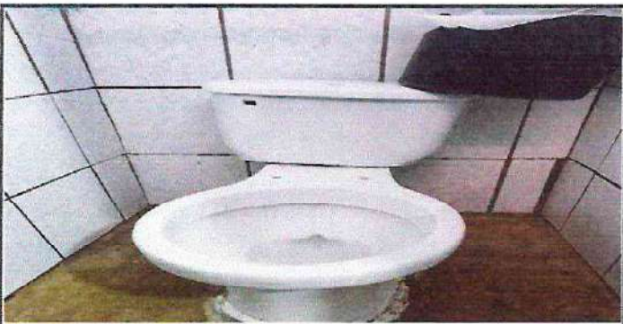
Foto 17: Instalación de inodoros completos (Sistema Push).
