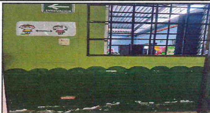
Foto 2: Pintura de paredes interiores, cocina.
