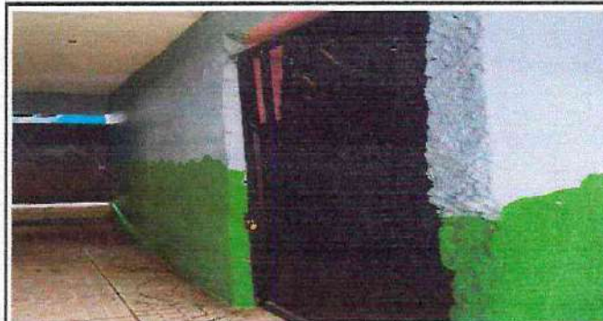
Foto 10: Mejoramiento de muro de block.
