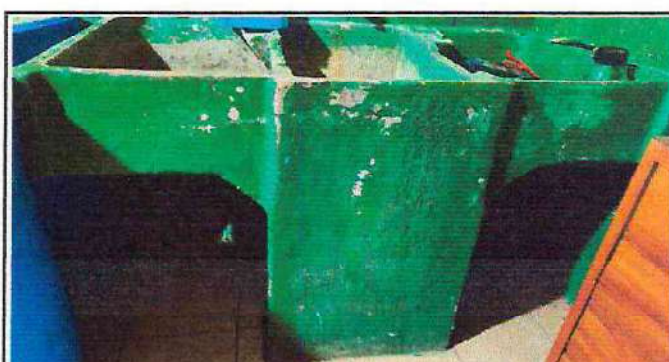
Foto 4: Sustrucción de pila por pila de concreto de 1.80 x 1.00 x 0.95 mts.
