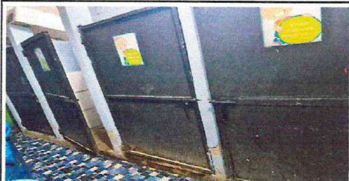
Foto 19: Mantenimiento de estructura (lijado, cambio de tubo, cepillado, sujeciones, aplicación de pintura) a puertas de servicios sanitarios.
