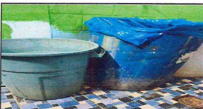
Foto 28: Suministro e instalación de depositos de agua (tinacos) de 1,700 lt.
