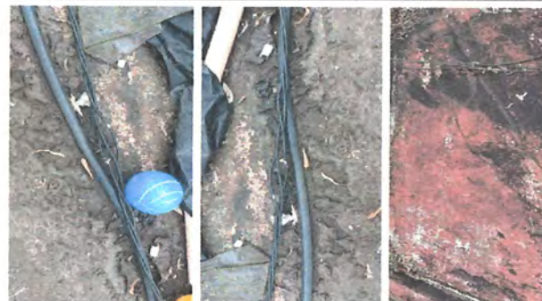
Foto 2: Limpieza, resanado e impermeabilizante de la losa en el área de sanitarios de niños y maestros.
