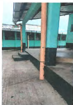
Foto 9: Colocación de codos de PVC de 4" y limpieza de bajadas de agua pluvial en el área de preprimaria y cancha deportiva.
