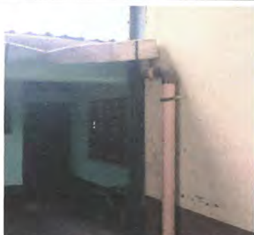
Foto 7: Sustitución de bajada de agua pluvial, tubo PVC y codos 4", frente de salones 5 y 6.
