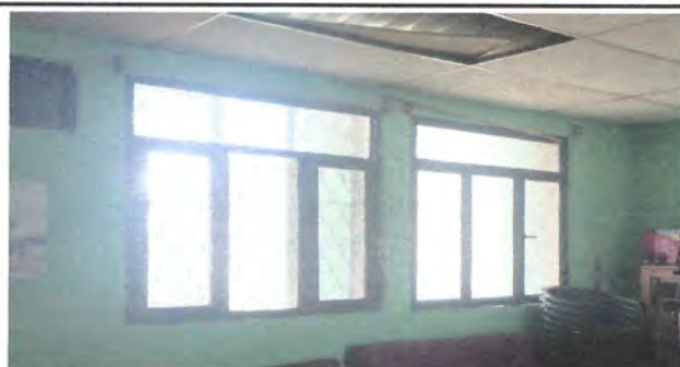
Foto 5: Sustitución de ventanas de madera por material PVC corredizas más vidrio por 1.40x1.50m en área de bodega y sala de maestros.
