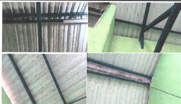
Foto1: Mantenimiento del techado, consistente en la reparación de goteras en los salones 2, 3, 6, 7 y 11.
