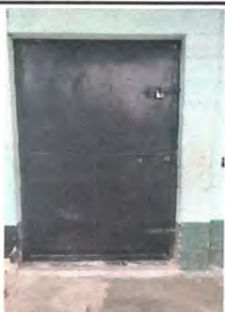
Foto 3: Sustitución de puerta de metal por uno nuevo ancho 1.05 x 2.10m área de cocina (pintura, chapa e instalación).
