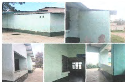
Foto 10: Aplicación de pintura exterior e interior en muros, incluye limpieza (Dirección, frente a servicios de sanitarios, cocina, escenario y bodega).
