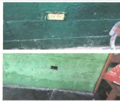
Foto 16: Sustitución de tomacorrientes dobles y un tomacorriente con swich en los salones 10 y 12 del área de preprimaria.
