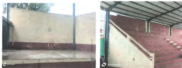
Foto 11: Aplicación de Pintura de aceite en muros, incluye limpieza de muros. En aulas, graderío y escenario.
