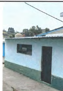
Foto 4: Sustitución de puerta de metal por uno nuevo ancho 0.95 x 2.10m área de bodega (pintura, chapa e instalación).
