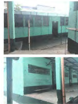
Foto 14: Sustitución de barrandas de metal ancho 3.10 x 1.15 m de largo, colocación y pintado.
