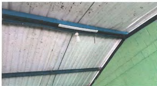
Foto 15: Sustitución de foco led, tecno lite, ahorradores para área del salón 2 nivel preprimario.
