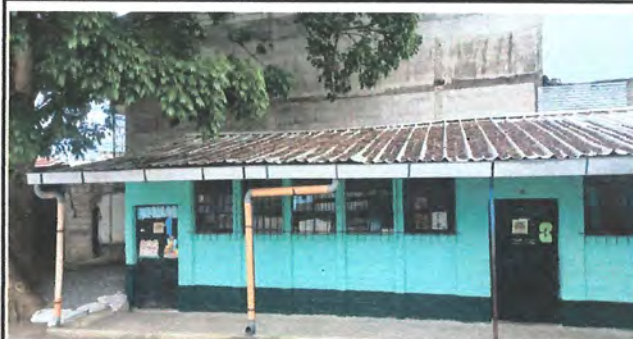
Foto 8: Limpieza de canales y techos en las áreas de preprimaria, primaria y cancha deportiva. Frente de los salones: 5, 6, 10, 11 y 12.
