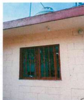
Foto 6: Instalacion de ventana
