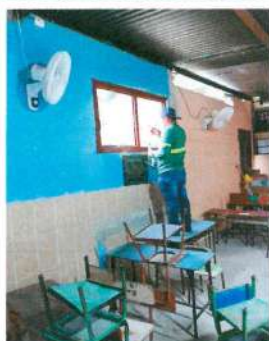
Foto 5: Instalacion de ventana
