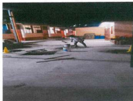
Foto 4: Trabajo de cajas
