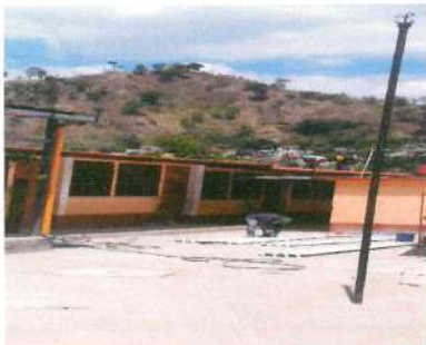
Foto1: Haciendo el techo
