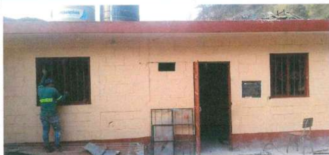
Foto 5: Instalación de ventanas
