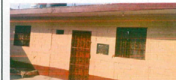
Foto 2: Instalación de tres ventanas en una aula, sustrucción de ventana en una clase y una instalación de una ventana a otra
