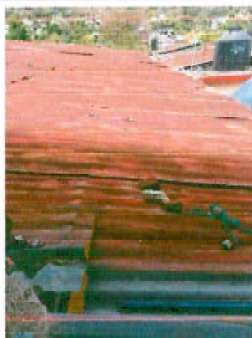
Foto 1: Sustrucción de lámina Alizin Calibre 26
