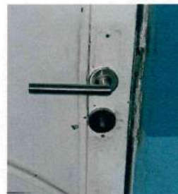
Sustitucion de Manija larga de acero inoxidable
