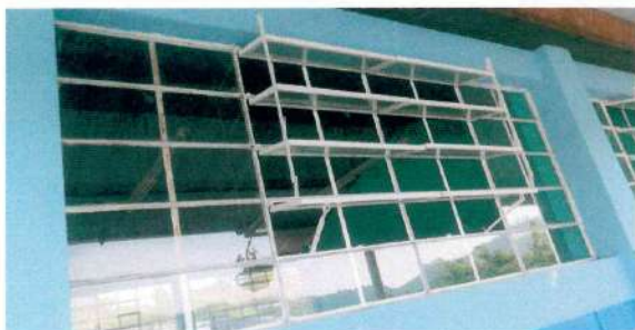
Mantenimiento a estructura de metal de ventana (lijado Aplicación de pintura anticorrosiva)
