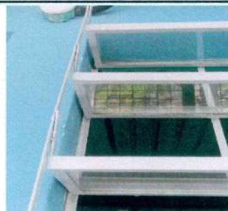
Sustitucion de vidrios de 5 MM
