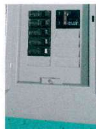
Sustitucion de tablero electrico de 12 polos incluye instalacion de 3 flipones nuevos
