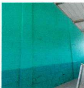
Pintura de muro exteriores e interiores incluye mano de obra
