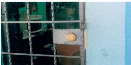
Sustitucion de chapa Yale
