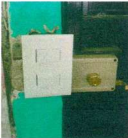
Suministro e Instalacion de interruptor doble
