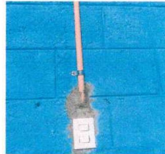
Suministro e instalacion de interruptor doble
