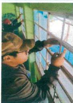
Mantenimiento a estructura de metal de ventana (lijado Aplicación de pintura anticorrosiva)
