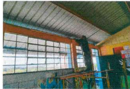
Suministro e instalacion de ducto y cableado electrico, incluye accesorios
