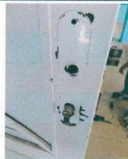
Sustitucion de Manija larga de acero inoxidable
