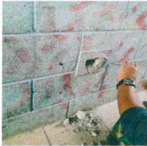
Sustitucion de tomacorrientes dobles
