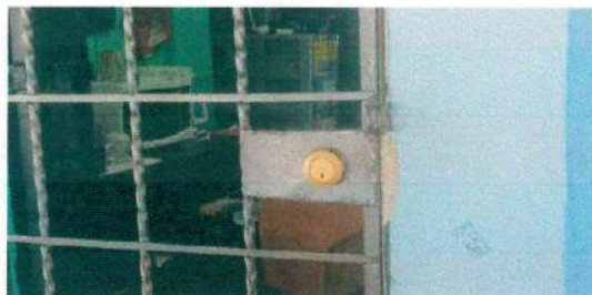
Sustitucion de chapa Yale
