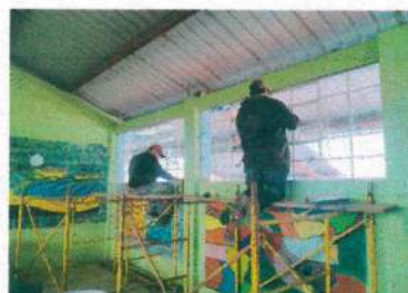
Sustitucion de vidrios de 5 MM
