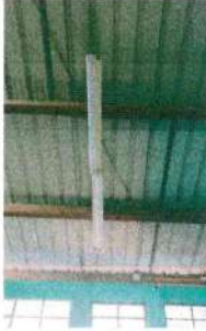
Sustitucion de lamparas tipo led incluye desinstalaciones e instalaciones de lamparas tipo led 2X40W
