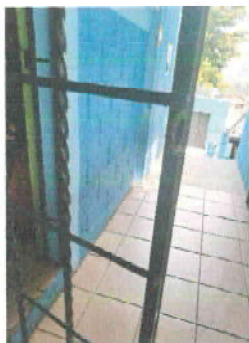
Foto 1: Sustrucción a chapa Yale
