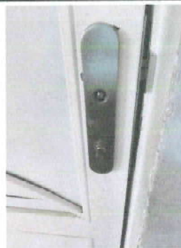
Foto 2: Sustrucción de chapa de manija larga de acero inoxidable
