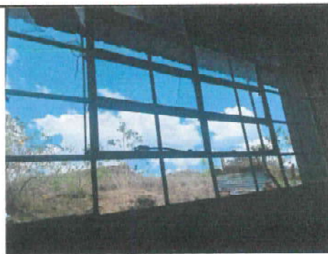
Foto 4: Sustrucción de vidrios quebrado e instalación de vidrios de 5mm.
