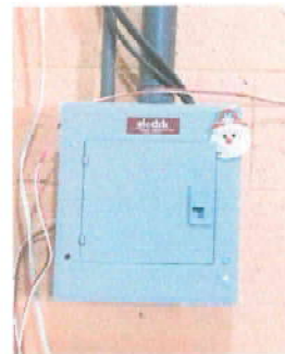
Foto 6: Sustrucción de tablero de filipones y mano de obra
