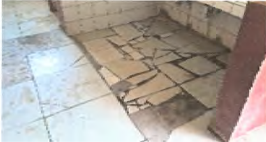
Foto 13: REPARACION DE PISO CERÁMICO
