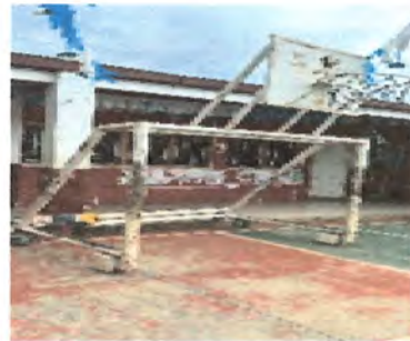
Foto 8: 19 mantenimiento a porterias de metal
