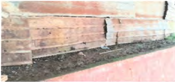
Foto 15: FABRICACIÓN DE (BASE) PLANCHA DE CEMENTO CON ELECTROMALLA
