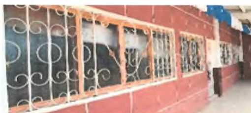
FOTO 4 MANTENIMIENTO A BALCONES DE METAL
