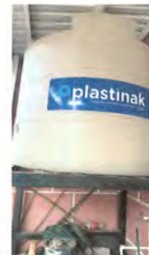
Foto 16 Sustitución de deposito de agua 2500 lt
