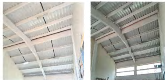
Foto 10: CAMBIO DE TORNILLOS Y APLICACIÓN DE SICAFLEX EN TORNILLOS DE TECHO
