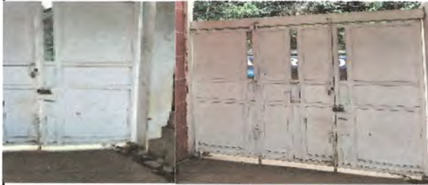
Foto 7: 12.1 MANTENIMIENTO A PORTON DE METAL
