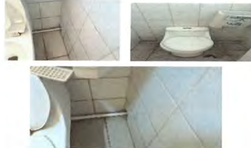
Foto 14: MODIFICACION DE TUBERÍA PARA BAÑOS Y LAVAMANOS DE NIÑOS Y NIÑAS
