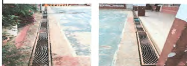
Foto 6: FABRICACION DE MARCO DE ANGULAR PARA SOPORTE DE REJILLA Y APLICACIÓN DE PINTURA
