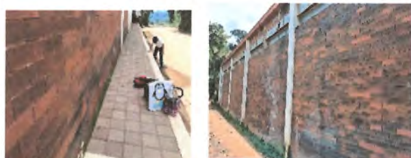
Foto 5: LIMPIEZA DE FACHAleta DE LADRILLO EN AREA EXTERIOR
