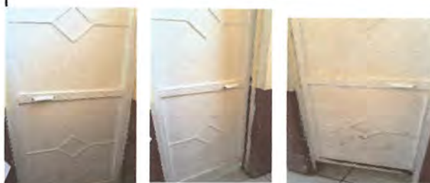
FOTO 2 mantenimiento a estructura en puertas de servicios sanitarios
