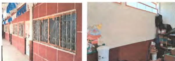
FOTO 3 APLICACIÓN DE PINTURA EN INTERIOR Y EXTERIOR DE AULAS
