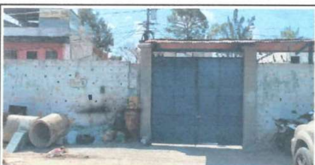
Foto 6: Pared interior de fachada de la escuela
