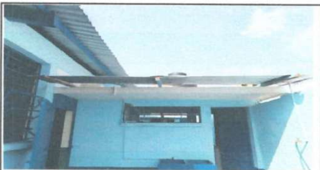
Foto 7 . Sustrucción de estructura de soporte de metal y lámina por lámina troquelada calibre 26 en modulos de sanitarios
