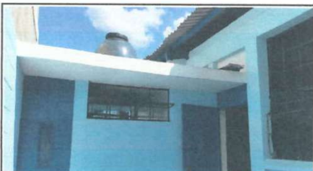
Foto 3: Reparación de Cenefas
