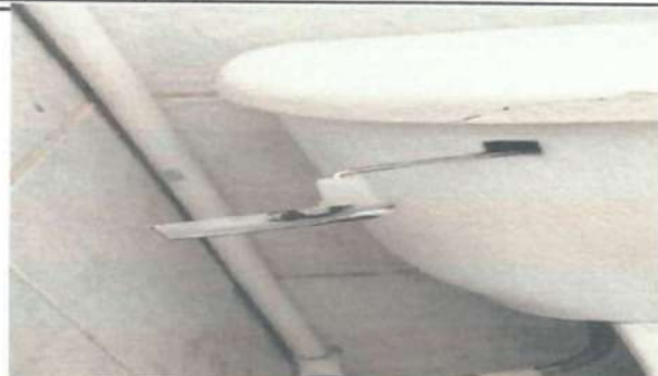
Foto 2: Sustitución de accesorios Sanitarios
