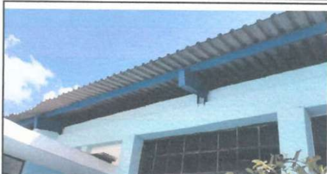
Foto 1: colocación de canal
