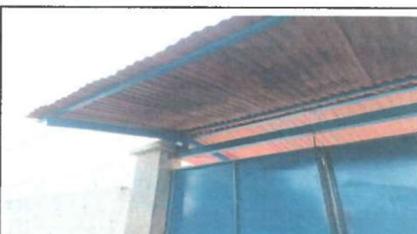
Foto 10: Mantenimiento y pintura de estructura y techo de entrada
