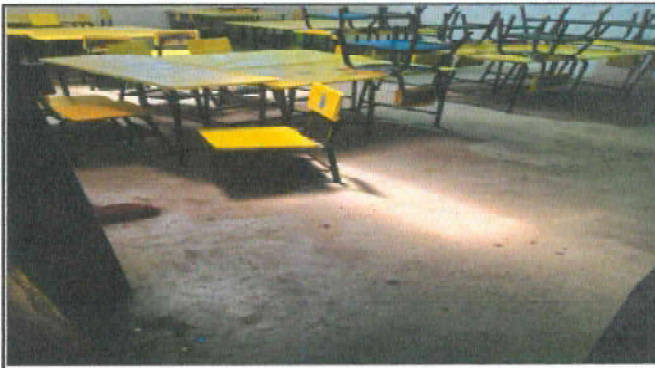
Foto 4: Instalación de piso ceramico
