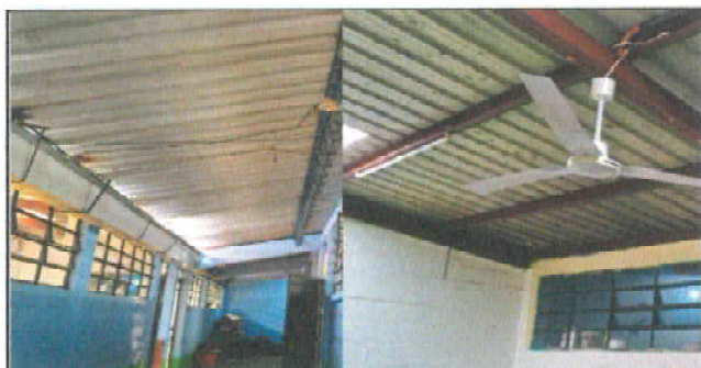
Foto 7: Instalacion de lamparas
