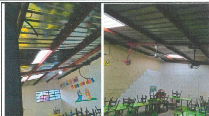
Foto1: Cambio de lamina por lamina troquelada Aluzinc
