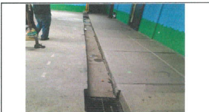
Foto 5: mejoramiento de drenaje pluvial en patio principal
