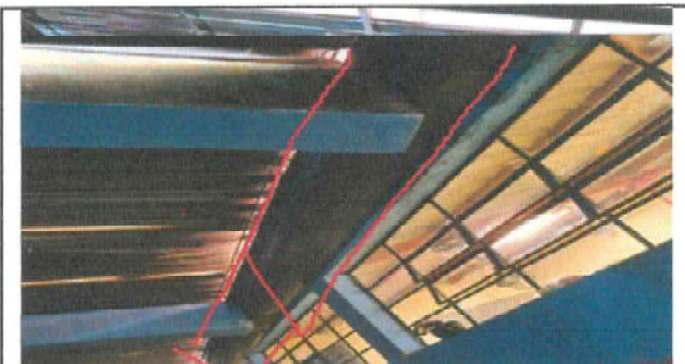
Foto 7: Instalacion de cedazo (cuando se levante el techo)
