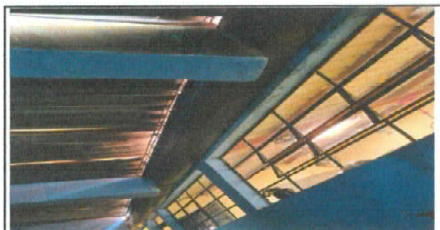
Foto 9: Cambio de canal pluvial de alto flujo
