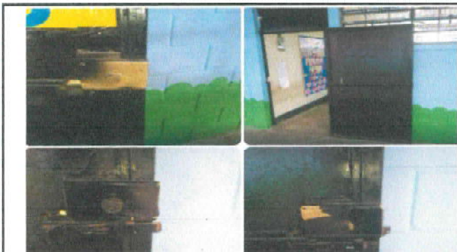
Foto 3: Cambio de Chapa de puerta de metal
