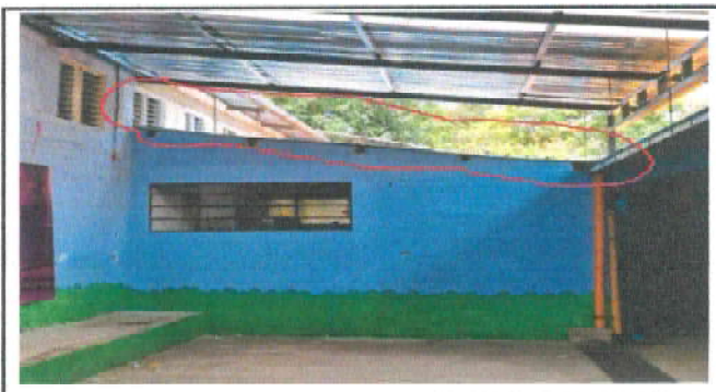
Foto 6: cerramiento lateral entre muro y techo
