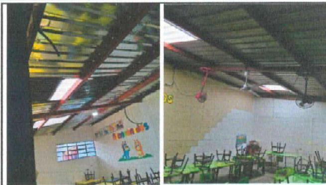
Foto 2: Cambio de estructura de techo
