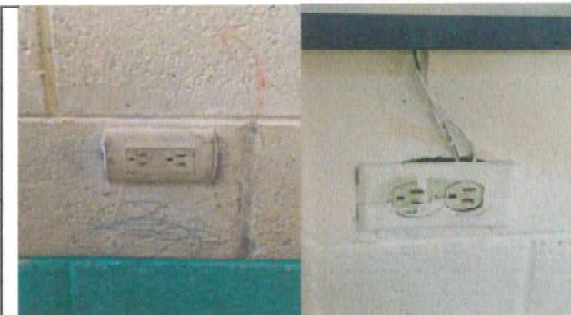
Foto 8: Instalacion de tomacorrientes dobles
