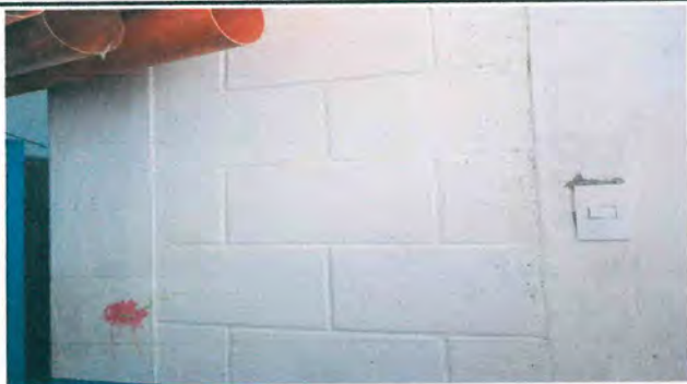
Foto 3: Pintura Acrílica en muros interiores y rezanamiento
