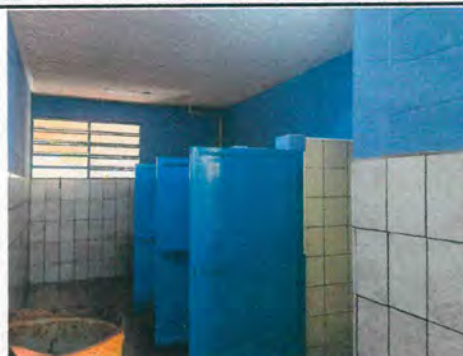
Foto 2: MANTENIMIENTO A PUERTAS DE SERVICIOS SANITARIOS
