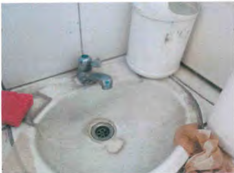
Foto1: SUSTITUCIÓN DE LAVAMANOS
