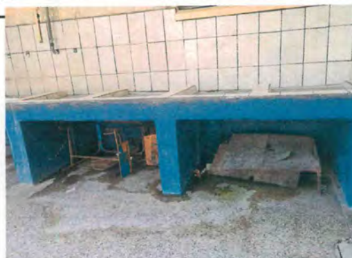
Foto 6: SUSTITUCIÓN DE AZULEJOS
