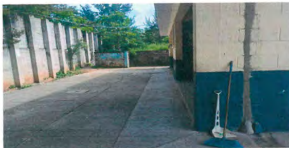
Foto 5: CAMBIO DE DRENAJES
