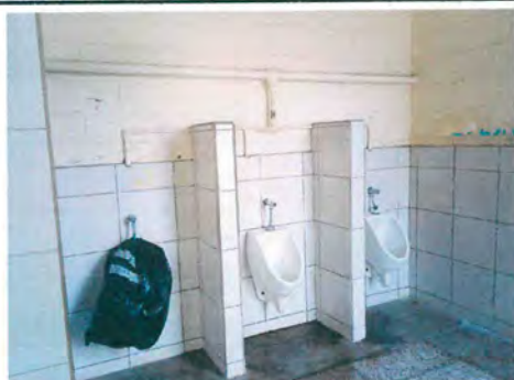
Foto 5: SUSTITUCIÓN DE MINGITORIOS
