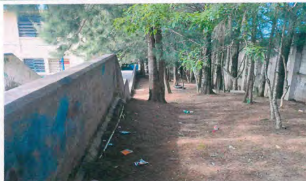
Foto 4: CAMBIO DE DRENAJES
