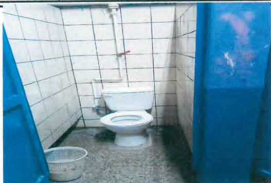
Foto1: SUSTITUCIÓN DE SANITARIOS
