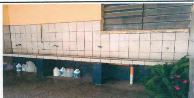
Foto 6: SUSTITUCIÓN DE AZULEJO
