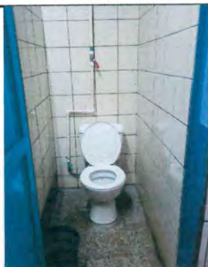
Foto 3: CAMBIO DE TUBERIA A PVC
