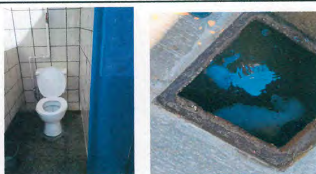
Foto 4: CAMBIO DE DRENAJES
