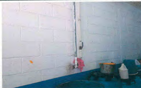
Foto 2: Pintura Acrílicas de muros interiores y rezanamiento
