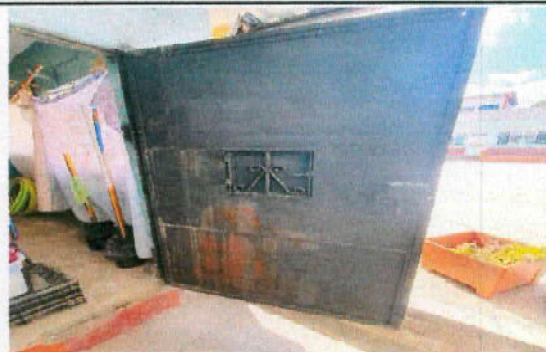
Foto 2: Mantenimiento de puerta, lijado y pintura
