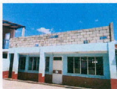
Foto 6: Repello, cernido y pintura de muros
