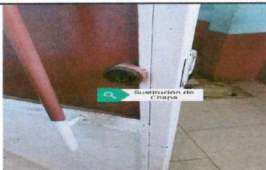
Foto 3: Sustitución de chapa
