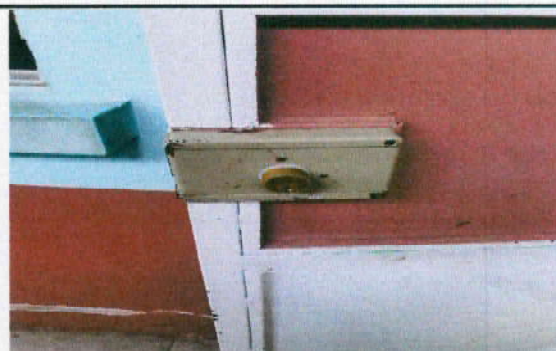
Foto 4: Sustitución de chapa
