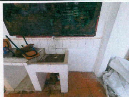
Foto 12: Fabricación y ampliación de pila, para uso de cocina.
