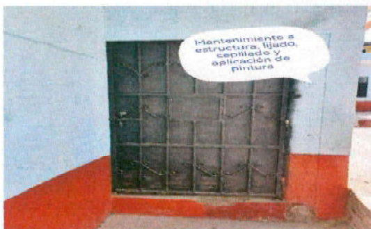
Foto 1: Mantenimiento de puerta, lijado y pintura
