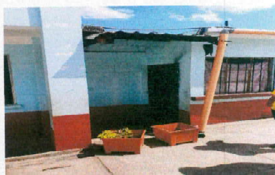
Foto 8: Sustitución de bajada de agua pluvial
