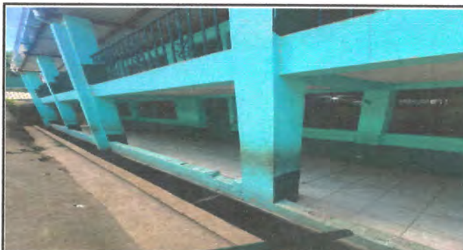
Foto 10: PINTURA DE EXTERIOR DE PRIMER NIVEL
