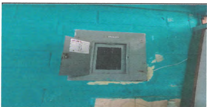
Foto 5: CAMBIO DE UBICACIÓN Y DE TABLERO DE FLIPONES
