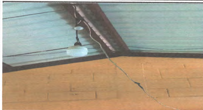
Foto 1: REVISION, CAMBIO DE PLAFONERAS, CABLEADO Y FOCOS PRIMERO Y SEGUNDO NIVEL
