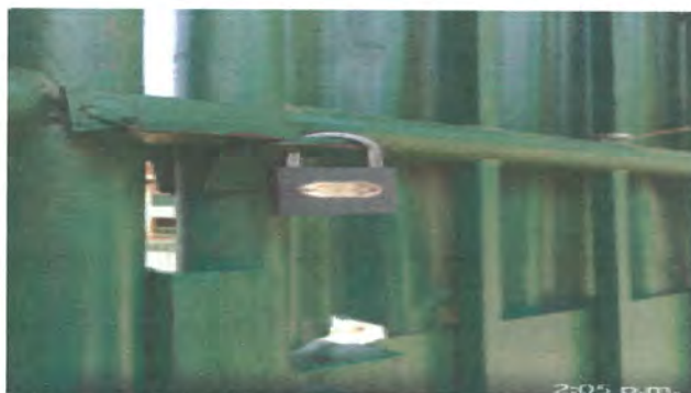
Foto 9: CAMBIO DE CHAPA DE PORTON GENERAL
