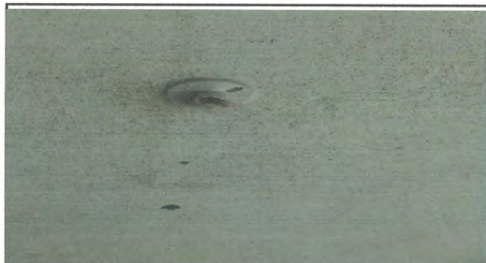
Foto 3: REVISION, CAMBIO DE PLAFONERAS, CABLEADO Y FOCOS PRIMERO Y SEGUNDO NIVEL
