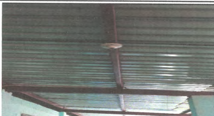
Foto 2: REVISION, CAMBIO DE PLAFONERAS, CABLEADO Y FOCOS PRIMERO Y SEGUNDO NIVEL
