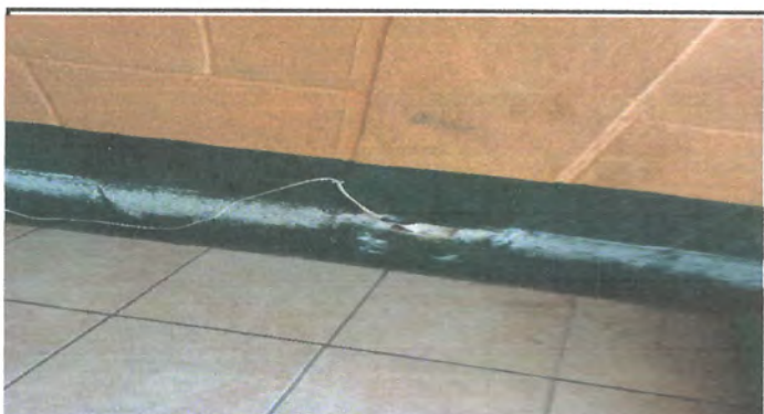
Foto 4: REVISION, CAMBIO DE TOMACORRIENTES Y CABLEADO PRIMERO Y SEGUNDO NIVEL
