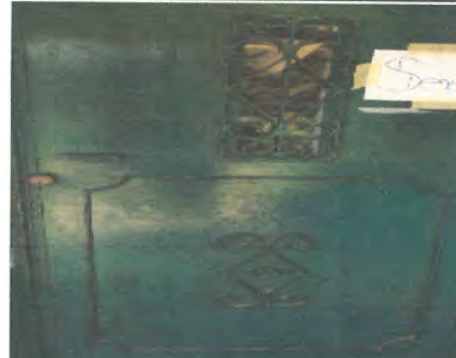
Foto 8: LIJADO, PINTADO Y CAMBIO DE CHAPAS DE 19 PUERTAS
