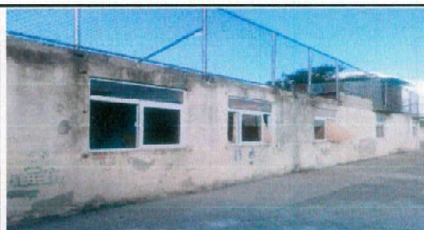
Foto 16: 21.1 Aplicación de repello en muro pared enfrente de cancha
