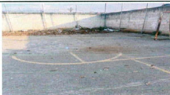
Foto13: 6.10 Marcaje de 6 canchas de 10 de ancho , suministro y aplicación de pintura asfáltica. Y cambio de dos llantas de portería
