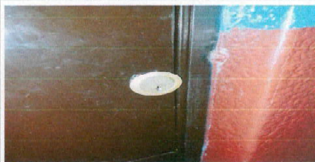
Foto 18: 4.2 Sustitucion de 2 chapas
