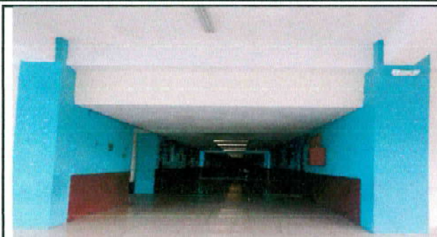
Foto 1: 19.5 Modulo 1 y 2 :Fabricación e instalación de 2 portones de rejas con chapa Yale con medidas de 3.90mts de ancho por 3.05 de alto. Ubicados accesos módulos primer nivel.
