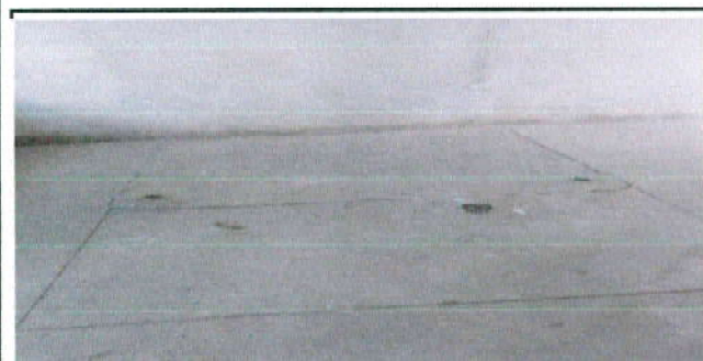
Foto 11 : 6.1 Reparacion de piso de concreto de aula de 2m ancho*2.10 de largo
