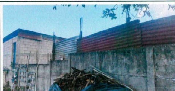
Foto 8: 15.3 instalacion de tubo hg chapa 18 1 pulgada redondo y malla galvanizada 27 MTScuadros 2x2 ( cuadros de malla enmarcados ) en basurero y área de cancha
