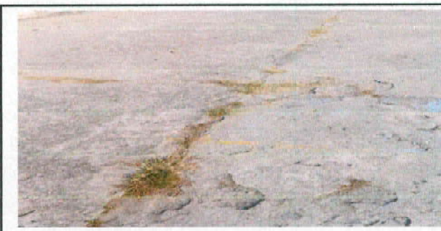
Foto 12: 6.1 Reparacion de cancha No.6 de 22 mts de larg *12 mts de ancho, sustituir torta de cemento
