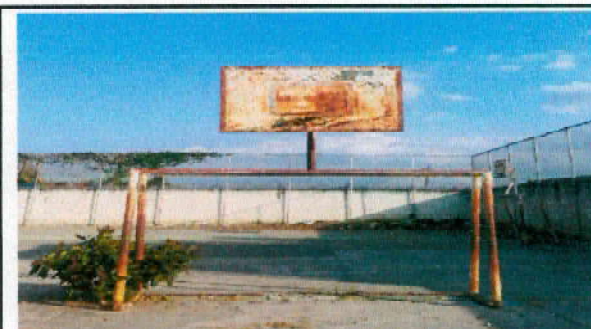
Foto 10: 2.1 Mantenimiento a estructura de soporte de metal de marcos de porterías de cancha 10 marcos 2.90*200 mts( lijado , cepillado, sujeciones, aplicación de pintura )
