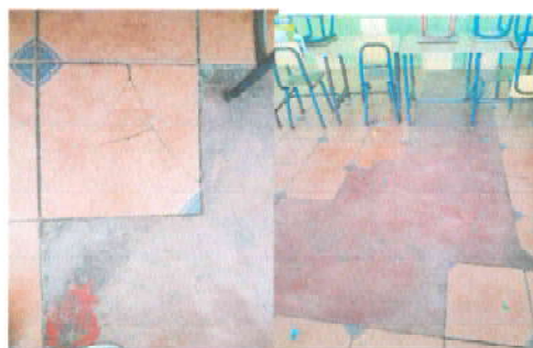
Foto 2: Sustitución de piso cerámico
