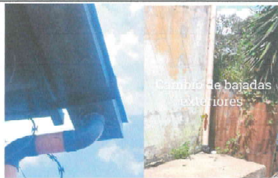
Foto 4: Sustitución de bajada de agua pluvial con tubo PVC de 3"
