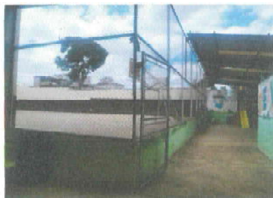
Foto 9: Reparación de tubo HG y malla galvanizada y tapar con privacinta
