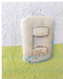
Foto13: sustitución de toma corrientes doble
