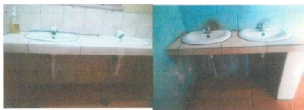
Foto 5: Sustitución de mezcladora lavamanos (contrallave y tubo de abasto)
