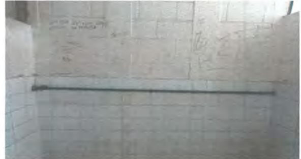
Foto 8: Sustrución e instalación de tubo de mingitorio y accesorios.
