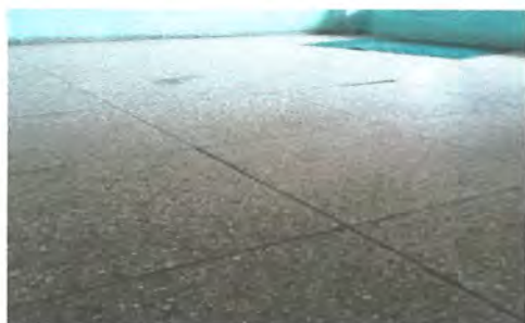
Foto 3: Sustitución de piso granito, salón de Primero A (primer módulo).
