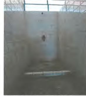
Foto 14: Instalación de azulejo en sanitario nuevo.
