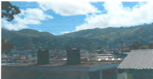
Foto 1: Impermeabilización de losa de sanitario.
