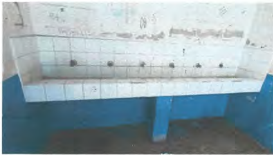
Foto 15: Instalación de chorros en lavamanos.
