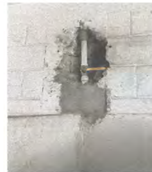
Foto 10: Elaboración e instalación de caja metálica para protección de llaves de paso. (en servicio sanitario del modulo central de niñas)
