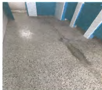
Foto 4: Mantenimiento de piso granito de sanitarios en modulo central de niños y niñas (Lijado, pulido de superficie de piso, aplicación de eliminador de sarro y manchas en superficie)
