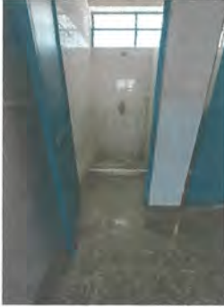
Foto13: Instalacion de sanitario nuevo, con accesorios, cuello, cera y tapadera. Eliminacion de bordillo y azulejo existente.
