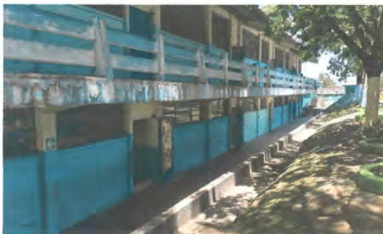
Foto 17: Mantenimiento y cambio de pintura en modulo 1 (limpieza, eliminación del moho y dos capas de pintura).
