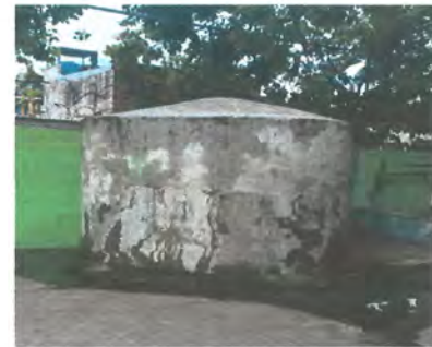
Foto 16: Reparación de sisterna de concreto, aplicación de resina epox interna e impermeabilizante en el area exterior (ubicada en la parte central de la escuela)
