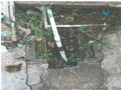
Foto 9: Sustrución e instalación de valvula y cheque en tubería de ingreso de agua y elaboración de caja de cemento para resguardo de tubería
