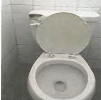
Foto 7: Sustrución de inodoro montaje y desmontaje de sanitarios, modulo central y módulo 1
