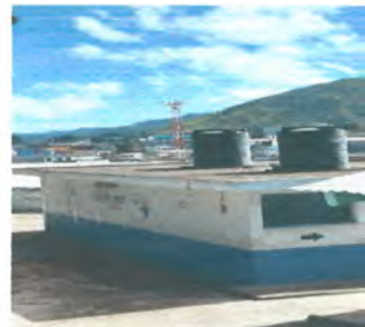
Foto 2: Limpieza de caídas de agua en losa de sanitarios.
