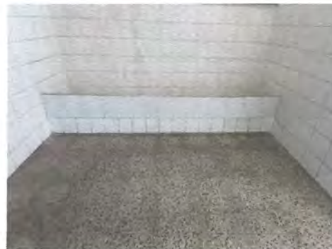
Foto : Mantenimiento de azulejos y lavamanos (limpieza de azulejos con limpiador marca fila PS87 PRO para limpieza y desengrasante profesional en sanitarios centrales de niñas, niños y lavamanos)
