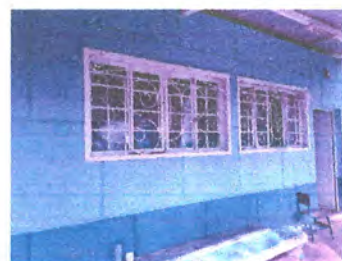
Foto 6: Aplicación de pintura en balcones.
