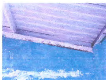
Foto 5: Sustitución y aplicación de impermeabilizante a canal.
