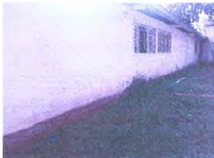
Foto 13: Sustrucción de banqueta en muros exteriores.
