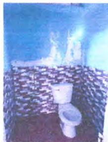
Foto 9: Aplicación de pintura en baños.
