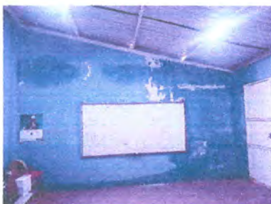
Foto 3: Aplicación de impermeabilización a paredes de aula con humedad.
