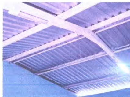
Foto 14: Sustrucción de lámpara tipo LED
