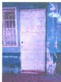
Foto 10: Aplicación de pintura a puertas.
