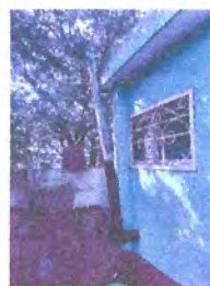
Foto12: Cambio de tubo de chimenea para cocina.
