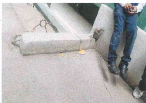
Foto 3: MURO Y BORDILLO SUBSANADO Y LEVANTADO
