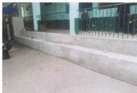
Foto 4: LEVANTAMIENTO DE MURO Y BANCA, ESPACIO PARA JARDIN
