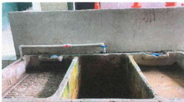
Foto 5: INSTALACION DE TUBERIA DE AGUA PARA PILA CON CAMBIO DE CHORRO
