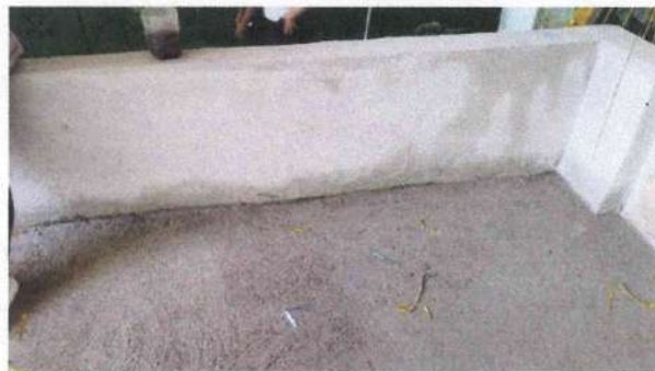
Foto 2: CONTINUACION DE MURO Y LEVANTADO
