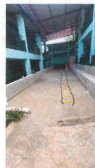
Foto 6: LEVANTAMIENTO DE LOSA MAS DE 15 CM CON CERNIDO RUSTICO
