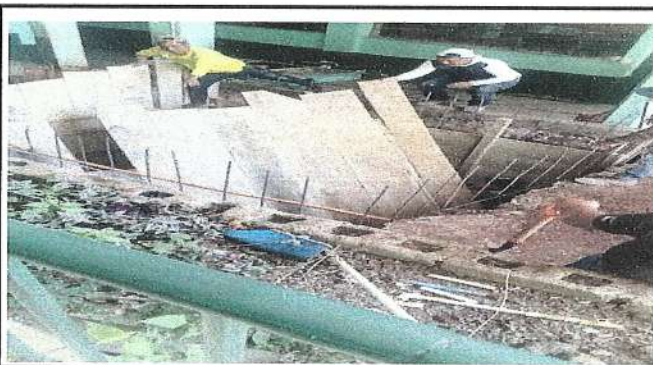
Foto 5: INSTALACION DE TUBERIA DE AGUA PARA PILA
