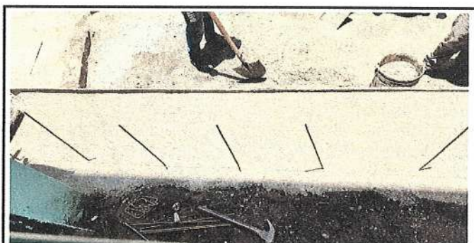
Foto 6: DEMOLICION DE MURO
