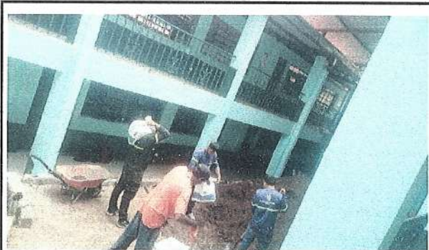
Foto 3: EN EL AREA DEL MURO DE SEGUNDO NIVEL INSTACION DE TUBERIA PARA ISTALAR ATINACOS QUE YA CONTAMOS CON ELLOS
