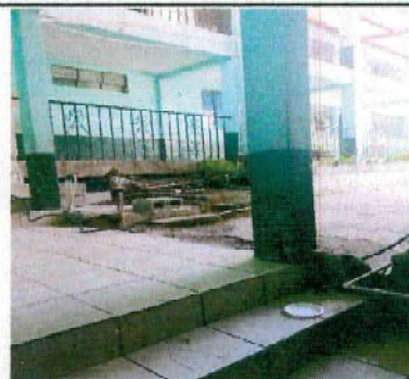
Foto 4: INSTALACION DE TUBERIA PARA COCINA
