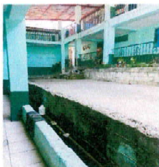
Foto 3: EN EL AREA DEL MURO DE SEGUNDO NIVEL INSTACION DE TUBERIA PARA ISTALAR ATINACOS QUE YA CONTAMOS CON ELLOS
