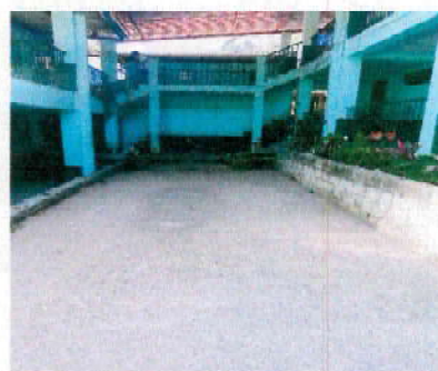
Foto 6: DEMOLICION DE MURO
