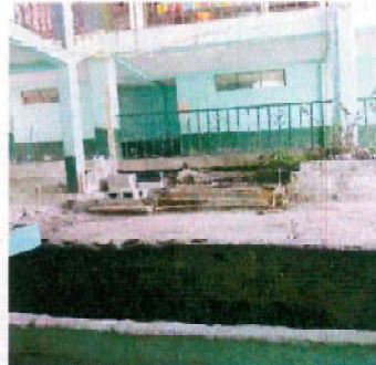
Foto 2: INSTALACION PARA BOMBA DE AGUA E HIDRONEUMATICO
