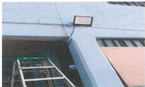
Foto 3: COLOCACIÓN DE REFLECTORES
