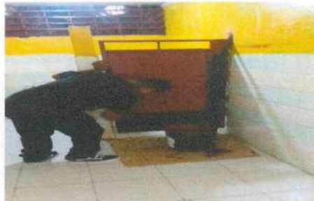
Foto 2: COLOCACIÓN DE PUERTA EN BAÑO
