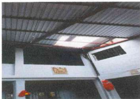
Foto1: COLOCACIÓN DE LÁMINA EN EL PATIO
