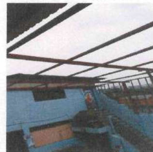
Foto 6: MANTENIMIENTO DE ESTRUCTURA
