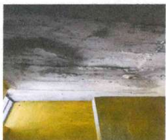
Foto 1: INICIO DE REPELLADO TECHO DEL BAÑO
