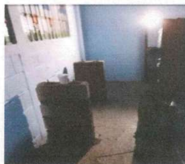
Foto 4: COLOCACIÓN DE COLUMNAS PARA PLANCHA DE COCINA
