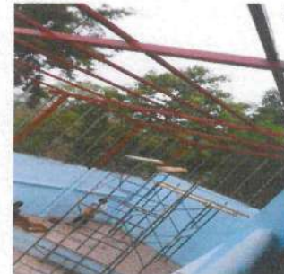
Foto 4: MANTENIMIENTO A ESTRUCTURA DE METAL
