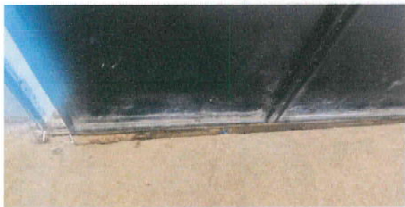
Foto1: Mantenimiento a porton de metal
