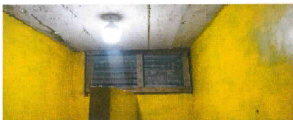
Foto1: fabricacion e instalacion de ventana en baño 1.40x .65 mts (baño niños)
