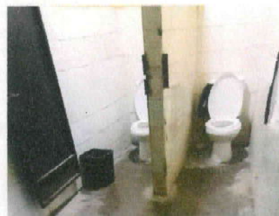
Foto 6: Instalación de puerta baño de niñas
