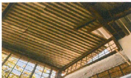
Foto 3: Sustrucción de lámina, por lámina troquelada aluzinc calibre 26
