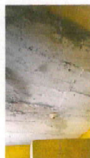
Foto 6: modulo 2: repello de cielo ( repello gris y acabado blanco)
