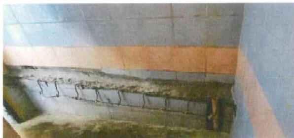
Foto1: modulo 1: reparacion e instalacion de azulejos de 20x20cm
