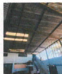
Foto 6: instalacion de bombillas led de 50wats
