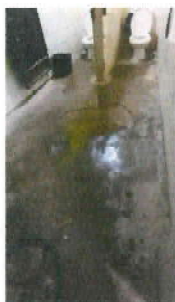
Foto 3: modulo 2: sustitucion e instalacion de piso de granito 30x30cm
