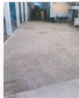
Foto 4: piso en losa de patio de 51x51cm
