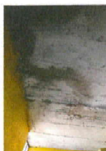
Foto 5: modulo 1: repello de cielo ( repello gris y acabado blanco)
