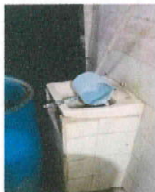
Foto1: sustitucion de lavamanos con plomeria + accesorios
