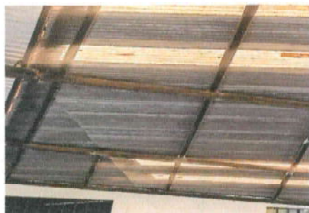
Foto 5: aplicación de pintura en estructura de techo
