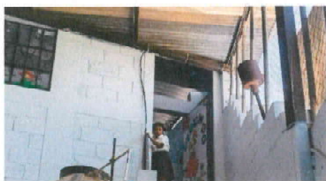
Foto 3: instalacion de acometida electrica (entubado de cableado principal con tubo 1 1/4 pvc
