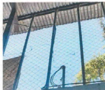
Foto 2: fabricacion e instalacion de reja 10.33x2 mts
