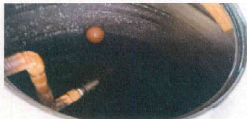
Foto 2: Sustitución de accesorios deposito de agua( flotes)
