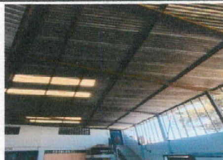
Foto 4: aplicación de pintura en estructura de techo
