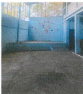
Foto 5: piso en losa de patio de 51x51cm
