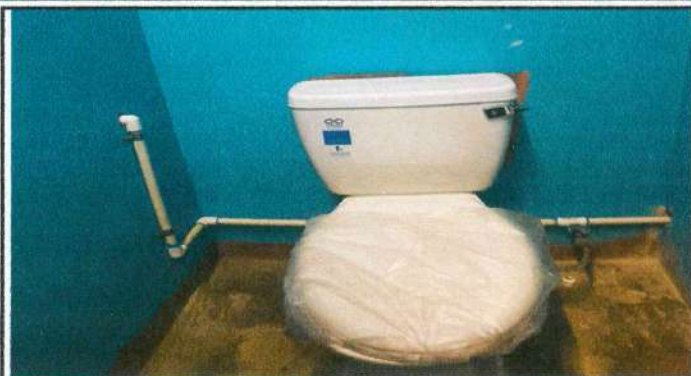
Foto1: Sustrucción de sanitarios y sus accesorios
