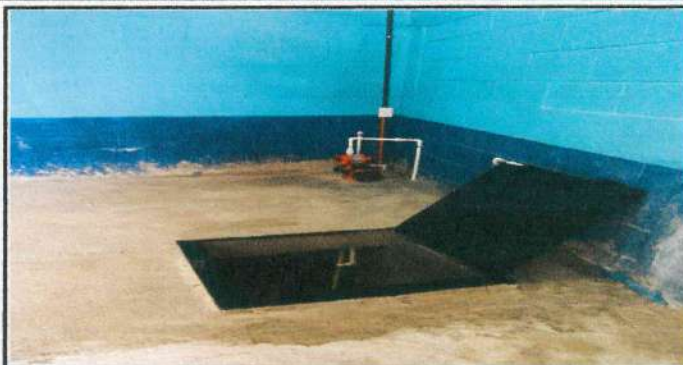
Foto 2: Implementación de cisterna para agua potable y bomba periférica
