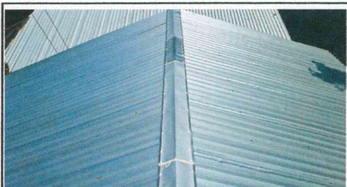
foto 4: Sustrucción de techo de 2 aulas
