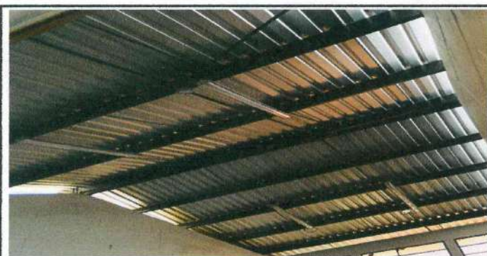
Foto 5: Mantenimiento a estructura metálica para el techo
