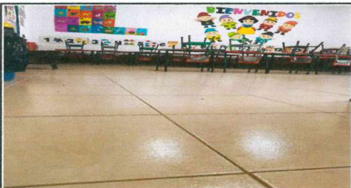
Foto 3: Sustrucción de piso en 3 aulas
