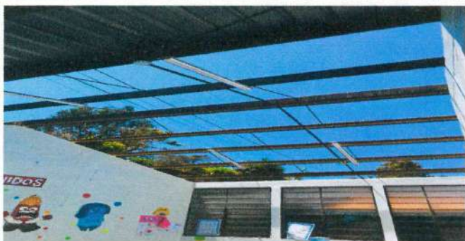
Foto 5: Mantenimiento a estructura metalica para el techo
