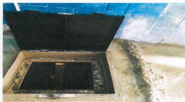
Foto 6: fundición de cisterna y colocacion de tapadera
