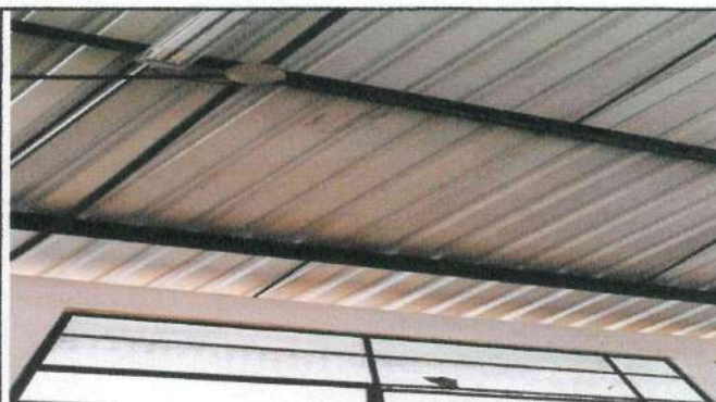
foto 4: Sustitución de techo de 2 aulas
