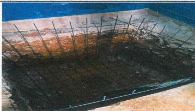
Foto 2: Implementación de cisterna para agua potable
