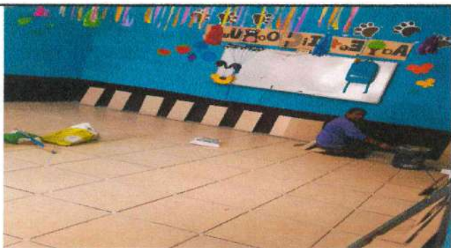
Foto 3: Sustitución de piso en 3 aulas
