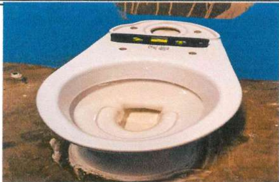
Foto1: Sustitución de sanitarios y sus accesorios
