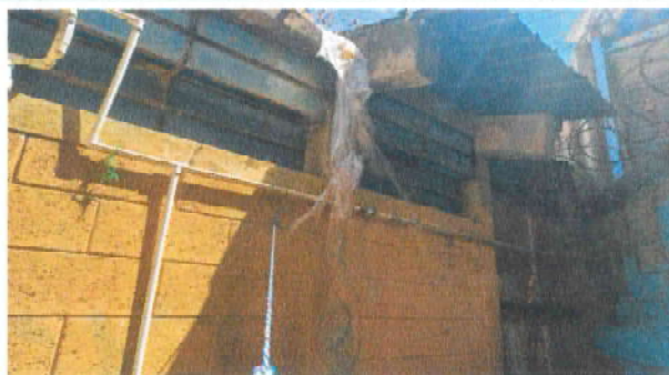
Foto 2: instalación de tubería principal de agua potable
