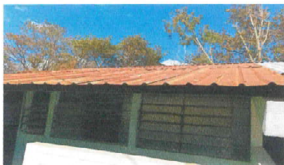
Foto 3: sustitución de cubierta de lamina
