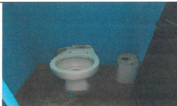
Foto 6: cambio de sanitarios
