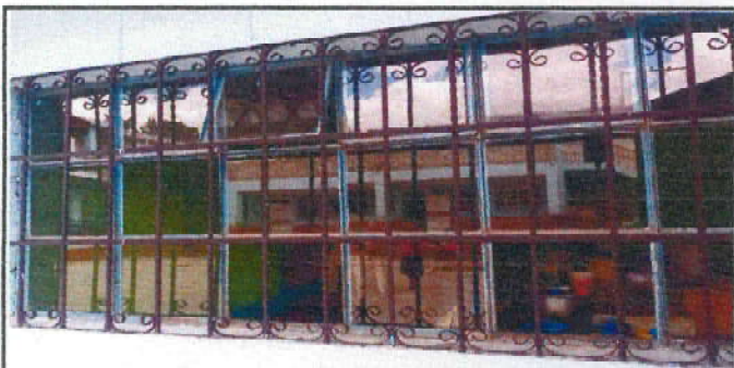
Foto 3: Sustrucion de ventana de metal por ventana pvc blanco en area de cocina.
