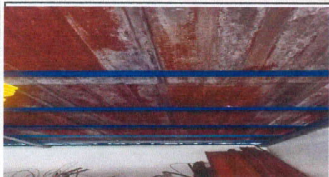
Foto 7: Sustitución de cableado electrónico incluye ducto eléctrico y sus accesorios.
