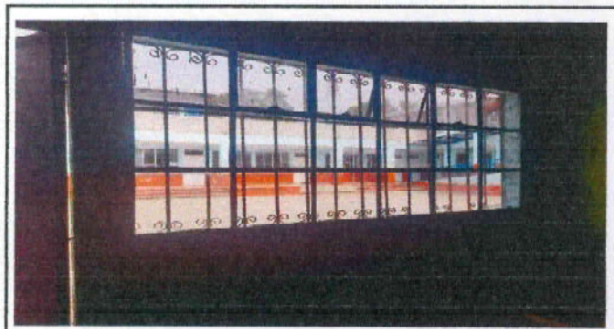
Foto 9: Suministro e instalación de persiana de aluminio para ventana de cocina.
