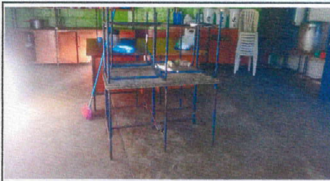
Foto 2: Suministro e instalacion de piso ceramico en cocina.
