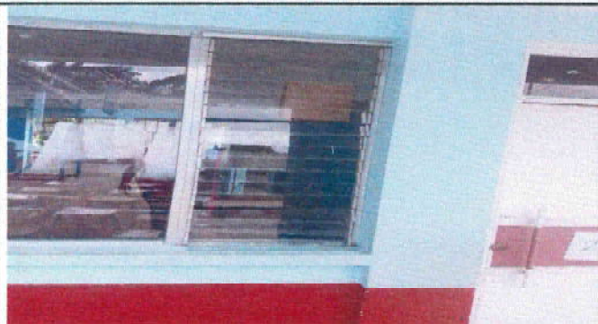
Foto 1: Sustrucion de ventanas por ventanas de metal por ventanas de pvc en toda el area del segundo nivel.
