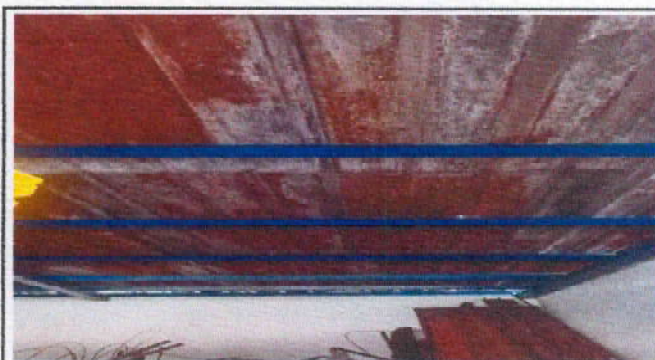
Foto 4: Sustrucion de lamina por lamina troquelada en salon de clase del segundo nivel.
