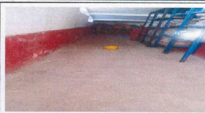
Foto 8: Sustitución y aplicación de cernido en área baja de la rampa.
