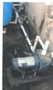
18.1 SUSTITUCION DE BOMBA 1.5 HP BERCKELEY 15LTHH 115/230V
