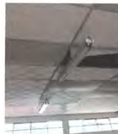
17.1 SUMINISTRO E INSTALACION DE LAMPARAS EN SALON PSICOLOGIA
