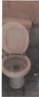
10.1 SUSTITUCION DE SANITARIO DEL SALON DE USOS MULTIPLES INCLUYE ACCESORIOS
