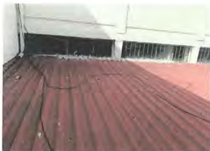
1.2 REPARACION DE TECHO DE BODEGA (INCLUYE FLASHING)
