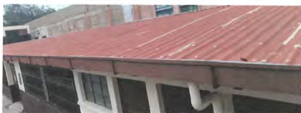
1.1 APLICACIÓN DE IMPERMIABILIZANTE EN LAMINA TROQUELADA DE SALON DE USOS MULTIPLES
