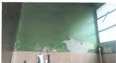
13.1 INSTALACION DE AZULEJO EN BAÑO DE DOCENTES
