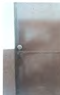
4.1 CAMBIO DE CHAPA YALE PARA PUERTA DE SANITARIO DE SALON DE USOS MULTIPLES
