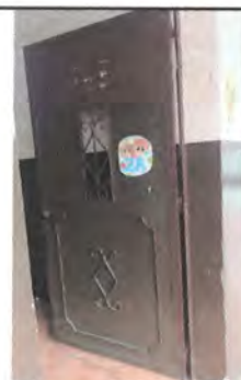
4.3 MANTENIMIENTO DE PUERTAS DE METAL, APLICACIÓN DE PINTURA A PUERTA DE SALONES DE CLASE
