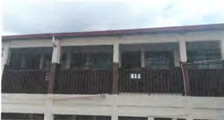
11.1 APLICACIÓN DE PINTURA A BARANDA
