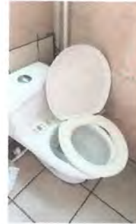
10.2 DESMONTAJE E INSTALACION DE INODORO Y LAVAMANOS DE PRIMER NIVEL
