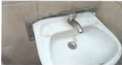
10.3 SUMINISTRO E INSTALACION DE LLAVES DE LAVAMANOS (INCLUYE LLAVE NUEVA Y ACCESORIOS MANGUERA FLEXIBLE PARA ABASTECIMIENTO)
