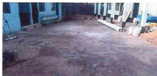
Foto 8: Suministro e instalación de caja de 60x60 cm con paredes de block y base fundida, con rejillas metálica, en área de patio para drenaje pluvial.
