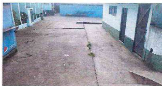
Foto 12: Reparación de piso de torta de concreto en área de guardanía, incluye demolición de torta existente, relleno y compactación de suelo
