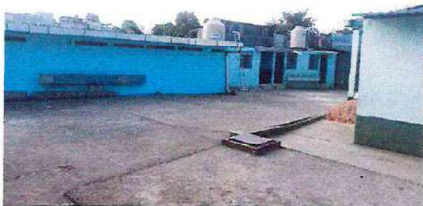
Foto 9: Suministro e instalación de caja de 70x80 con paredes de block y base fundida, con rejilla metálica en área de patio para drenaje pluvial.
