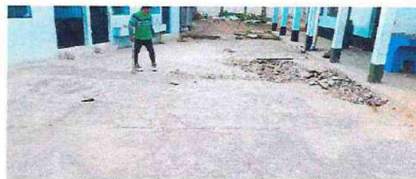
Foto 2: Reparación de piso de torta de concreto en área de patio, incluye demolición de torta existente, relleno y compactación de suelo.
