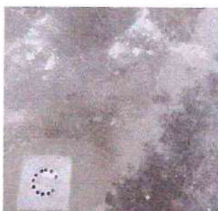
Foto 5: Suministro e instalación de reposadera de 15x15 cm incluye sifón.
