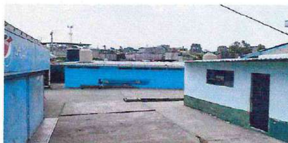
Foto 10: Sustitución de tubo de 4" para drenaje de agua pluvial en área de guardanía y patio (Incluye zanqueo, relleno y compactación).
