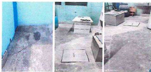
Foto 1: Reparación de piso de torta de concreto en área de cocina, incluye demolición de torta existente, relleno y compactación de suelo.
