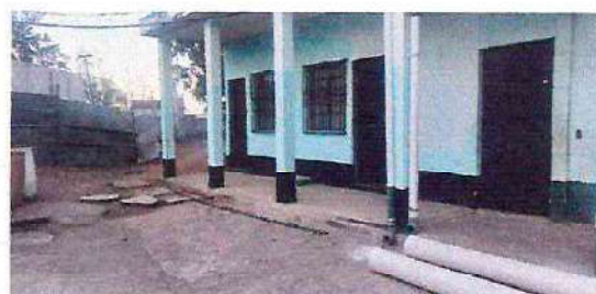
Foto 4: Sustitución de tubería de 4" para desfogue de aguas negras de sanitarios y para conectar el drenaje de la pila (incluye demolición de piso existente, excavación, instalación de tubería, relleno y compactación).
