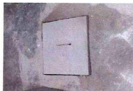
Foto 6: Reparación de caja reunidora de 50x60 cm, con tapadera de aluminio.
