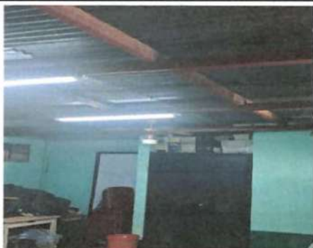
Foto1: Desmontado de techo, pintado de costaneras y montado de laminas nueva
