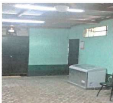
Foto 3: Pintura de fachada internas y cambio de laminas sala computacion
