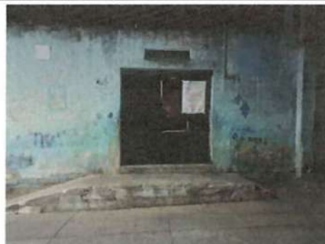
Foto 4: Pintura fachada externas con galones de pintura anticorrosiva
