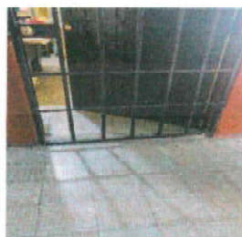
Corte de reja y puerta de la dirección del segundo nivel
