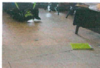
Piso en las aulas de sexto A y B del segundo nivel
