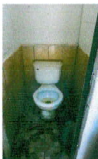
Foto 5: modulo 2: cambio de inodoro
