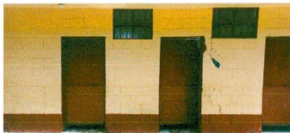
Foto 11: ampliación de pared
