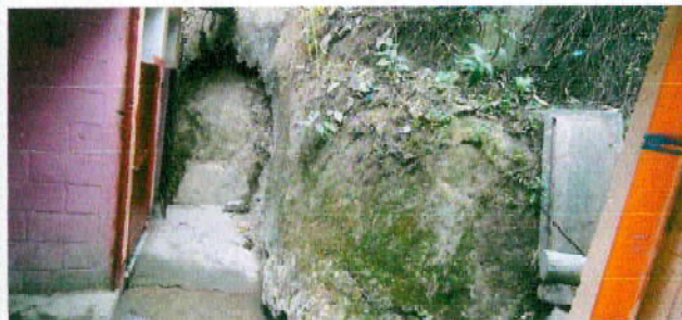
Foto 20: modulo 1: reparacion de repello y cernido en pared ( incluye pintado) area de baños
