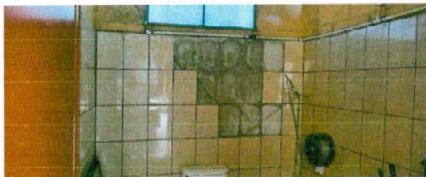
Foto 13: modulo 1: cambio de azulejo
