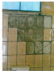
Foto 14: modulo 1: repello de pared
