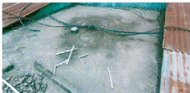
Foto 9: impermeabilización de techo
