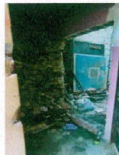
Foto 22: Sellado de grietas y fisuras en muros (area bodega)
