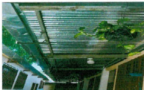
Foto 3: aplicacion de pintura en estructura de techo
