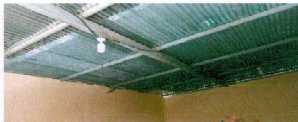
Foto 4: aplicacion de pintura en estructura de techo
