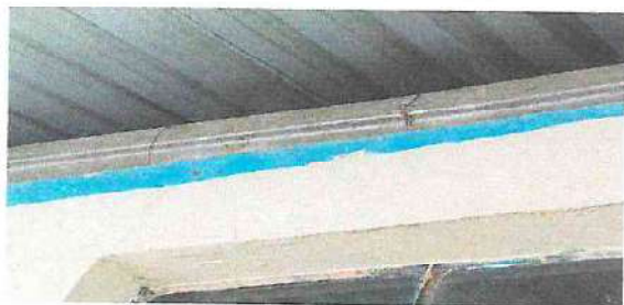
SUSTITUCIÓN DE LA LÁMINA Y CEDAZO EN MAL ESTADO POR ESTRUCTURA METÁLICA CON CEDAZO TIPO MOSQUITERO.
