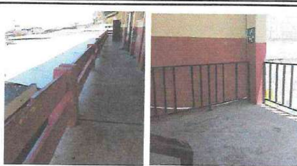
Foto 2: DEMOLICIÓN DE BARANDA EN MAL ESTADO, FABRICACIÓN DE BARANDA DE METAL, INCLUYE LA BARANDA DEL SEGUNDO NIVEL Y LA DE LAS GRADAS DE AMBOS LADOS.
