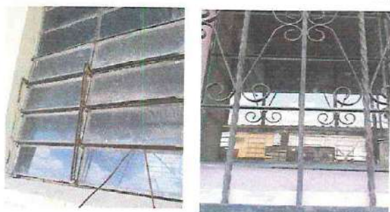
Foto 5: REPARACIÓN DE LOS VENTANALES DEL TODO EL MÓDULO NO. 4, CAMBIO DE 77 VIDRIOS QUEBRADOS.
