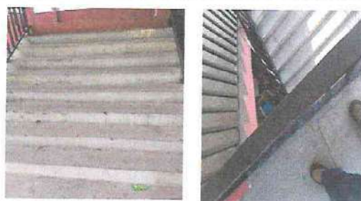
Foto 4: REPARACIÓN Y CERNIDO DE GRADAS, DESCANZO.
