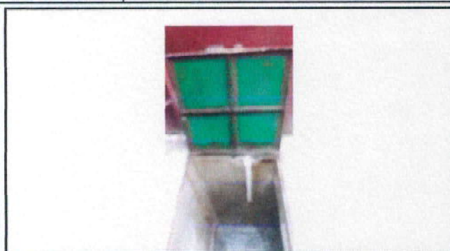
Foto 7: REPARACION DE DRENAJE REPARACION DE TAPADERA DE METAL
