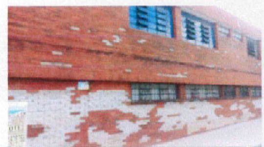
Foto 5: 15 MUROS PERIMETRALES 15.1 REPARACION, DESINSTALACION Y INTALACION DE LADRILLOS DE MURO EN PAREDES EXTERIORES
