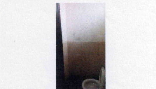
Foto 4: 13 REPARACION O SUSTITUCION DE AZULEJO 13.1 INSTALCION DE AZULEJO ( 20 BAÑOS )
