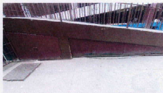
Foto 2: 4 PUERTAS DE METAL 4.3 SUSTITUCION DE PUERTA DE METAL POR BLOCK
