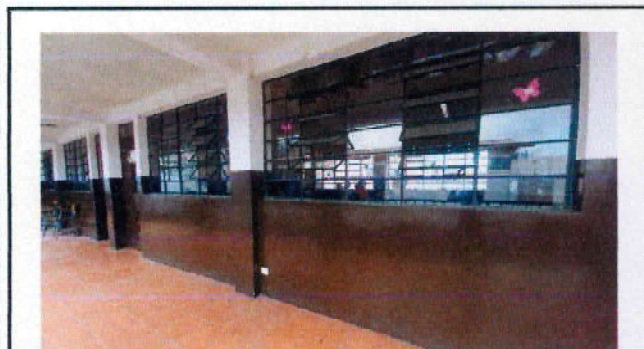
Foto 9: 19 MANO DE OBRA ESPECIALIZADA (ALBAÑILERIA, HERRERIA, ELECTRICIDAD Y PLOMERIA) 19.2 FABRICACION E INTALACION DE BALCON DE VENTANA DE HIERRO
