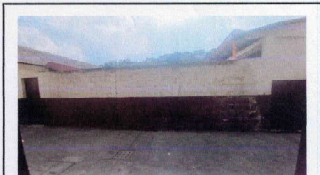
Foto 10: 19 MANO DE OBRA ESPECIALIZADA (ALBAÑILERIA, HERRERIA, ELECTRICIDAD Y PLOMERIA) 19.9 DEMOLICIÓN DE MURO
