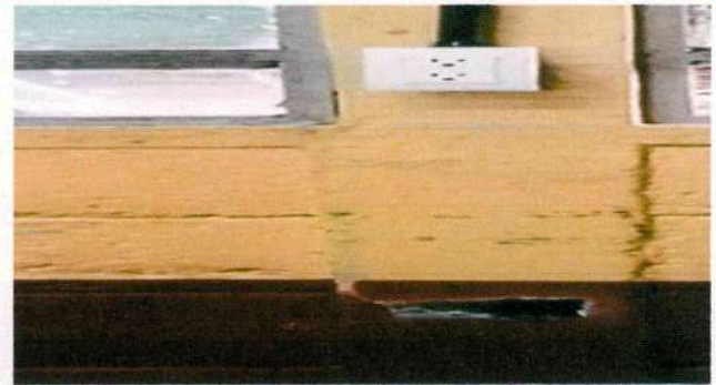
Foto 20: SUSTITUCIÓN DE INTERRUPTORES EN SALONES Y CORREDORES MÓDULO 2
