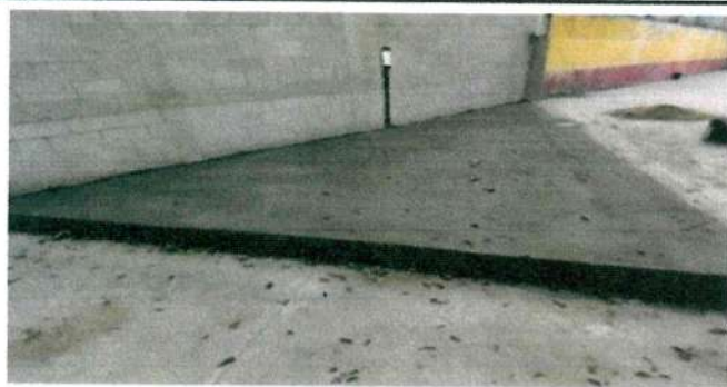
Foto 9: SUSTITUCIÓN Y FUNDICIÓN DE PISO DE CONCRETO CON 15 CMS DE ESPESOR INCLUYE ELECTROMALLA EN PATIO DELANTERO DE LA ESCUELA FRENTE A MÓDULO 1
