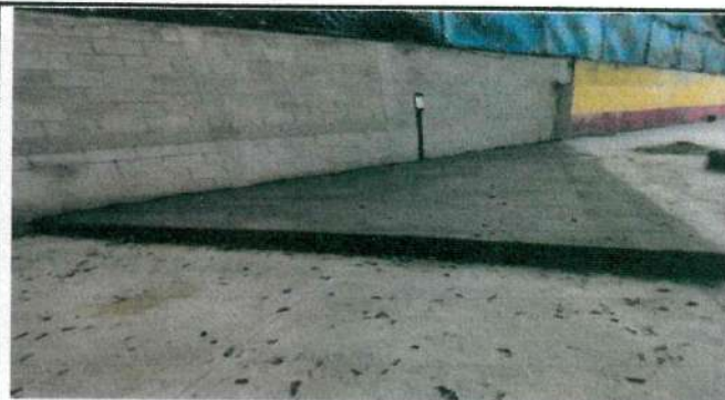
Foto 10: SUSTITUCIÓN Y FUNDICIÓN DE PISO DE CONCRETO CON 15 CMS DE ESPESOR INCLUYE ELECTROMALLA EN PATIO DELANTERO DE LA ESCUELA FRENTE A MÓDULO 1
