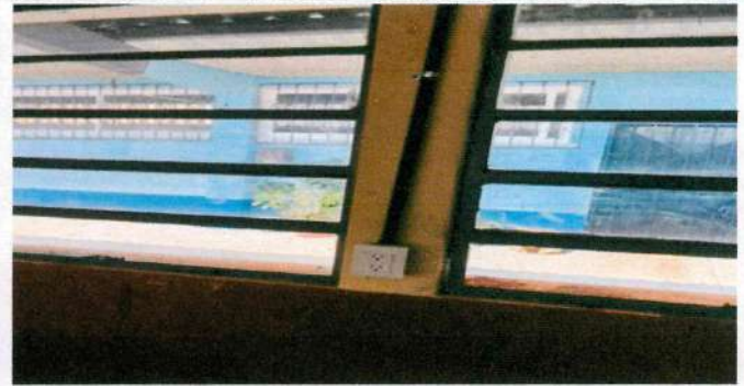
Foto 22: SUSTITUCIÓN DE TOMACORRIENTES DOBLES SALON MODULO 2
