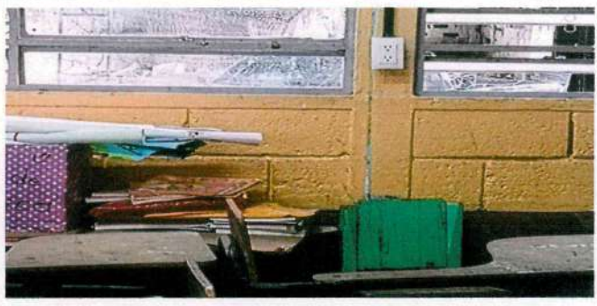
Foto 24: SUSTITUCIÓN DE TOMACORRIENTES DOBLES SALON MODULO 2
