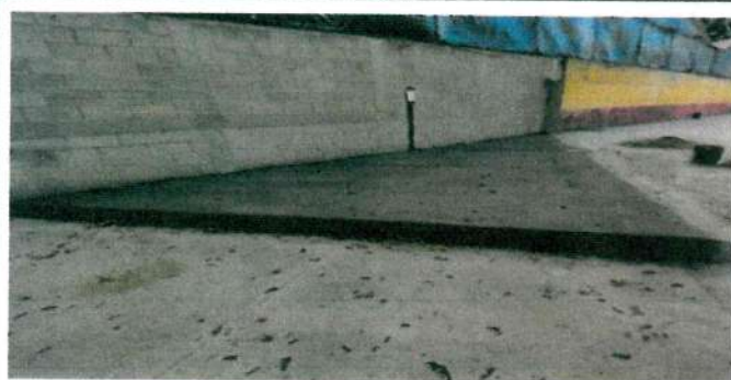
Foto 11: SUSTITUCIÓN Y FUNDICIÓN DE PISO DE CONCRETO CON 15 CMS DE ESPESOR INCLUYE ELECTROMALLA EN PATIO DELANTERO DE LA ESCUELA FRENTE A MÓDULO 1
