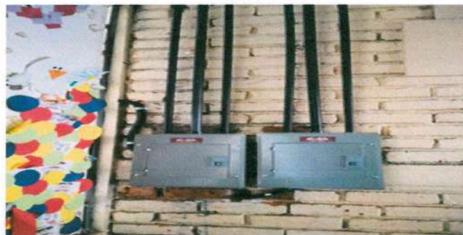
Foto 26: INSTALACIÓN DE 3 TABLEROS ELÉCTRICOS CON SUS ACCESORIOS
