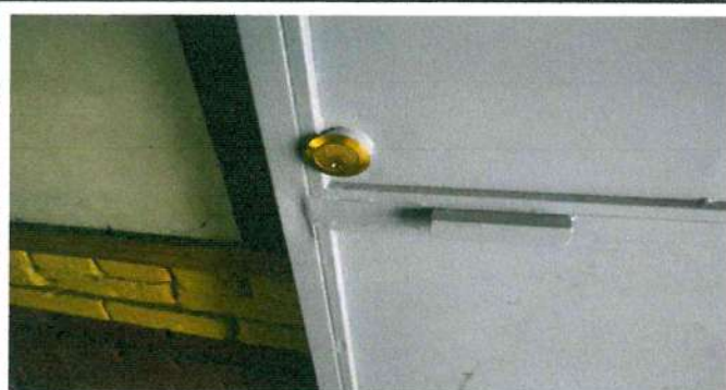
Foto 3: SUSTITUCIÓN DE CHAPA EN BODEGA MÓDULO 2
