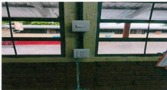
Foto 28: SUSTITUCIÓN DE CABLEADO ELECTRICO, INCLUYE DUCTO, CABLE ELÉCTRICO, CAJAS OCTAGONALES Y CAJAS RECTANGULARES, ABRAZADERA, TORNILLOS EN SALONES Y CORREDORES DE MÓDULO 2
