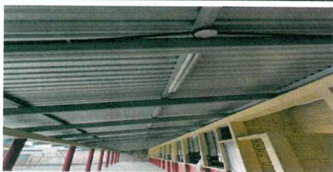
Foto 17: SUSTITUCIÓN DE LAMPARAS POR LAMPARAS TIPO LED CONTRA POLVO Y HUMEDAD, EN 4 EN MÓDULO 1, 23 EN MÓDULO 2 Y 23 EN MÓDULO 3
