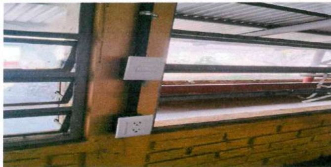
Foto 23: SUSTITUCIÓN DE TOMACORRIENTES DOBLES SALON MODULO 3
