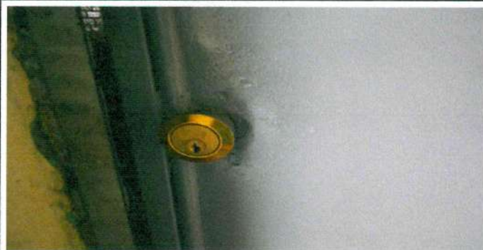
Foto1: INSTALACIÓN DE CHAPA EN MÓDULO 2
