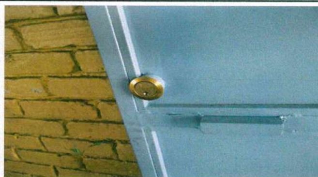
Foto 2: SUSTITUCIÓN DE CHAPA EN BODEGA MÓDULO 3
