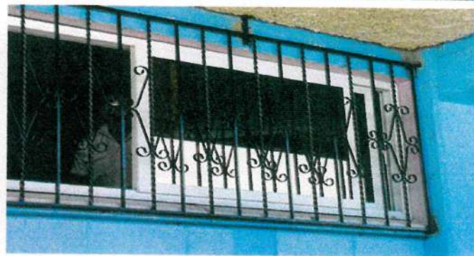
Foto 8: SUSTITUCIÓN DE ESTRUCTURA DE METAL DE VENTANA POR VENTANA PVC BLANCO EN MÓDULO 4 PRIMER NIVEL
