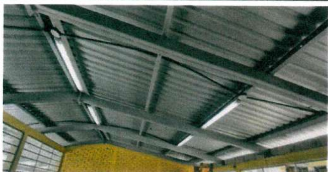
Foto 15: SUSTITUCIÓN DE LAMPARAS POR LAMPARAS TIPO LED CONTRA POLVO Y HUMEDAD, EN 4 EN MÓDULO 1, 23 EN MÓDULO 2 Y 23 EN MÓDULO 3
