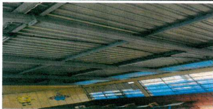
Foto 13: SUSTITUCIÓN DE LAMPARAS POR LAMPARAS TIPO LED CONTRA POLVO Y HUMEDAD, EN 4 EN MÓDULO 1, 23 EN MÓDULO 2 Y 23 EN MÓDULO 3
