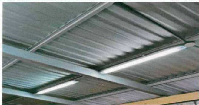
Foto 27: SUSTITUCIÓN DE CABLEADO ELECTRICO, INCLUYE DUCTO, CABLE ELÉCTRICO, CAJAS OCTAGONALES Y CAJAS RECTANGULARES, ABRAZADERA, TORNILLOS EN SALONES Y CORREDORES DE MÓDULO 2
