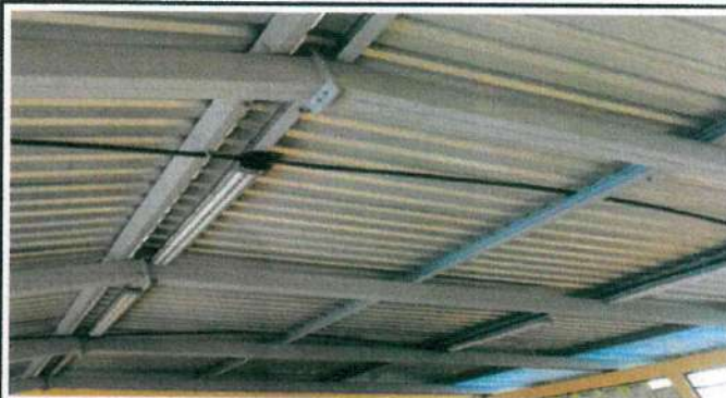
Foto 14: SUSTITUCIÓN DE LAMPARAS POR LAMPARAS TIPO LED CONTRA POLVO Y HUMEDAD, EN 4 EN MÓDULO 1, 23 EN MÓDULO 2 Y 23 EN MÓDULO 3
