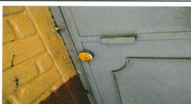
Foto 4: SUSTITUCIÓN DE CHAPA EN BAÑO DE NIÑOS MÓDULO 2
