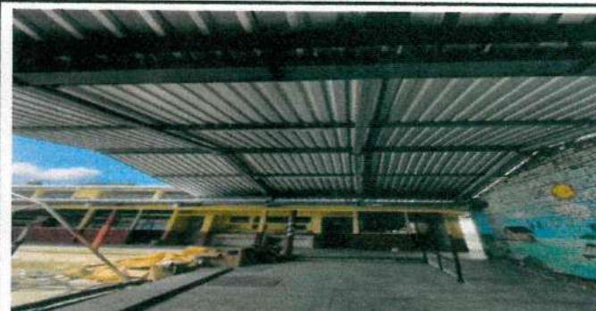
Foto 16: SUSTITUCIÓN DE LAMPARAS POR LAMPARAS TIPO LED CONTRA POLVO Y HUMEDAD, EN 4 EN MÓDULO 1, 23 EN MÓDULO 2 Y 23 EN MÓDULO 3
