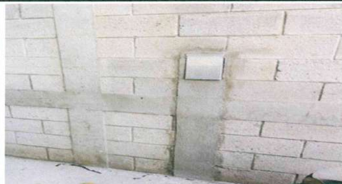
Foto 25: INSTALACIÓN DE 3 TABLEROS ELÉCTRICOS CON SUS ACCESORIOS
