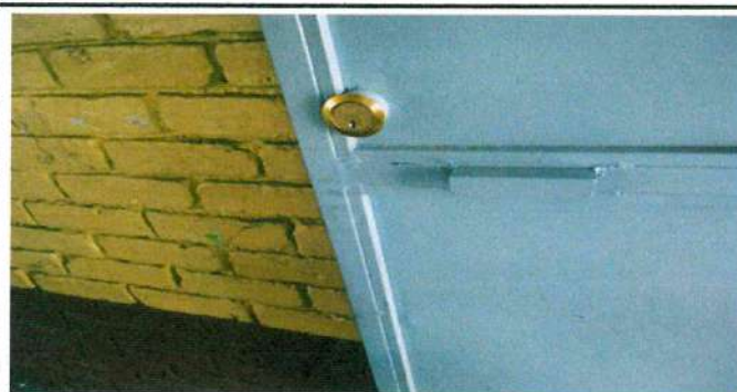
Foto 5: INSTALACIÓN DE CHAPA EN SALÓN MÓDULO 3
