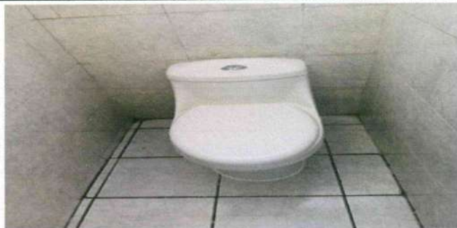
Foto 34: DESISNTALACIÓN E INSTALACION DE 3 SANITARIOS BAÑO MÓDULO 1
