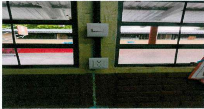
Foto 19: SUSTITUCIÓN DE INTERRUPTORES EN SALONES Y CORREDORES MÓDULO 3
