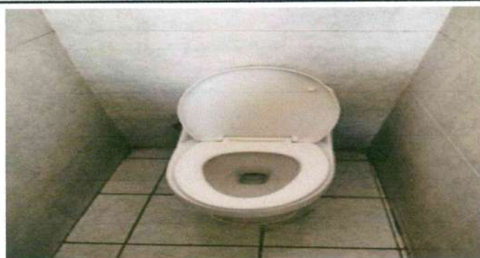
Foto 33: DESISNTALACIÓN E INSTALACION DE 3 SANITARIOS BAÑO MÓDULO 1
