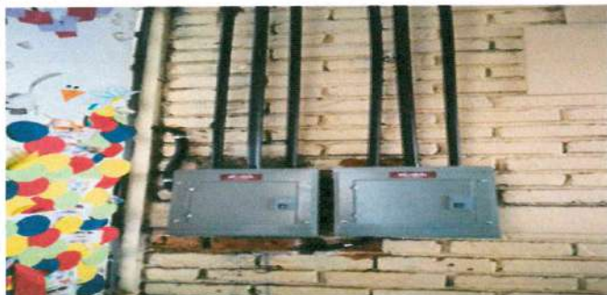
Foto 31: INSTALACION DE ACOMETIDA ELÉCTRICA INCLUYE ACCESORIOS Y CABLEADO DESDE CAJA PRINCIPAL A CAJA DE FLIPONES
