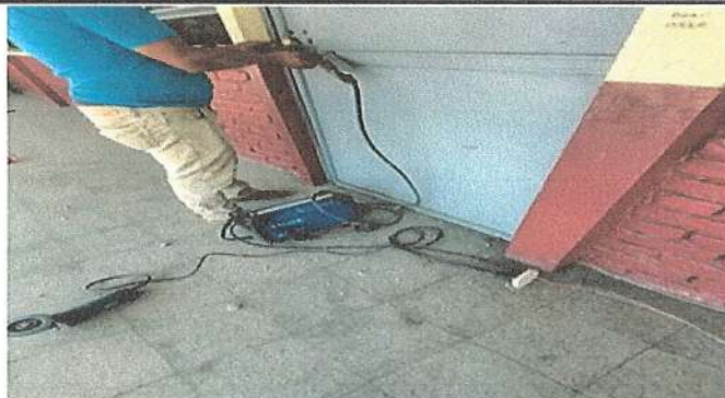
Foto1: INSTALACIÓN DE CHAPA EN MÓDULO 2
