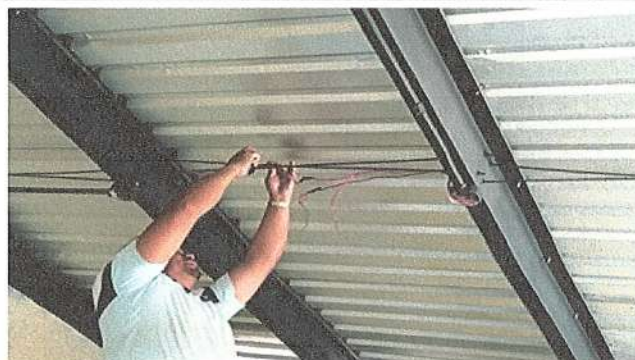
Foto 14: SUSTITUCIÓN DE LAMPARAS POR LAMPARAS TIPO LED CONTRA POLVO Y HUMEDAD, EN 4 EN MÓDULO 1, 23 EN MODULO 2 Y 23 EN MÓDULO 3
