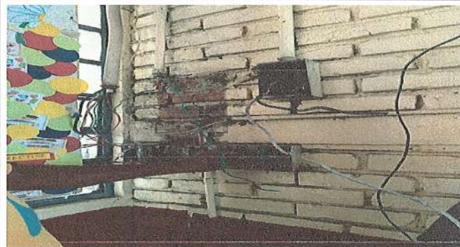
Foto 26: INSTALACIÓN DE 3 TABLEROS ELÉCTRICOS CON SUS ACCESORIOS
