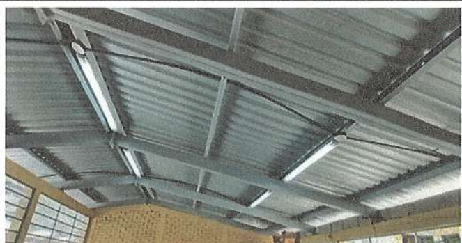
Foto 15: SUSTITUCIÓN DE LAMPARAS POR LAMPARAS TIPO LED CONTRA POLVO Y HUMEDAD, EN 4 EN MÓDULO 1, 23 EN MODULO 2 Y 23 EN MÓDULO 3
