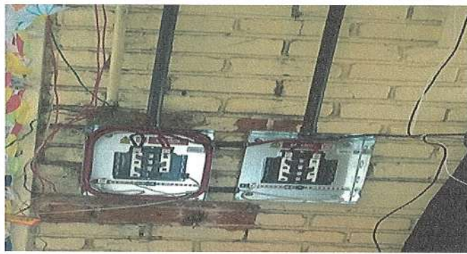
Foto 31: INSTALACION DE ACOMETIDA ELÉCTRICA INCLUYE ACCESORIOS Y CABLEADO DESDE CAJA PRINCIPAL A CAJA DE FLIPONES
