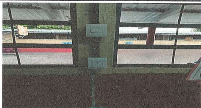
Foto 19: SUSTITUCIÓN DE INTERRUPTORES EN SALONES Y CORREDORES MÓDULO 3
