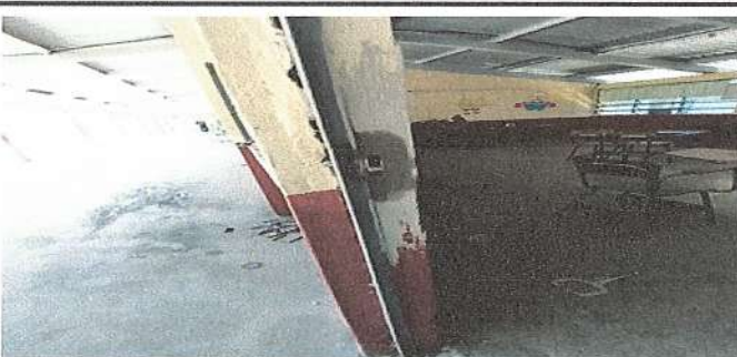
Foto 5: INSTALACIÓN DE CHAPA EN SALÓN MÓDULO 3
