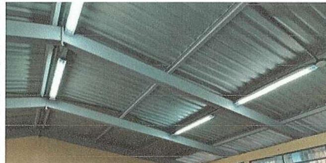
Foto 30: SUSTITUCIÓN DE CABLEADO ELECTRICO, INCLUYE DUCTO, CABLE ELÉCTRICO, CAJAS OCTAGONALES Y CAJAS RECTANGULARES, ABRAZADERA, TORNILLOS EN SALONES Y CORREDORES DE MÓDULO 2
