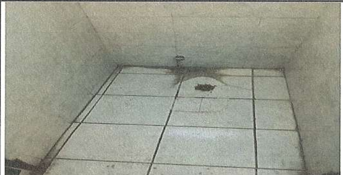
Foto 34: DESISNTALACIÓN E INSTALACION DE 3 SANITARIOS BAÑO MÓDULO 1
