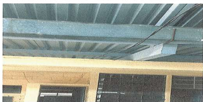
Foto 17: SUSTITUCIÓN DE LAMPARAS POR LAMPARAS TIPO LED CONTRA POLVO Y HUMEDAD, EN 4 EN MÓDULO 1, 23 EN MODULO 2 Y 23 EN MÓDULO 3
