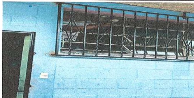
Foto7: SUSTITUCIÓN DE ESTRUCTURA DE METAL DE VENTANA POR VENTANA PVC BLANCO EN MÓDULO 4 PRIMER NIVEL
