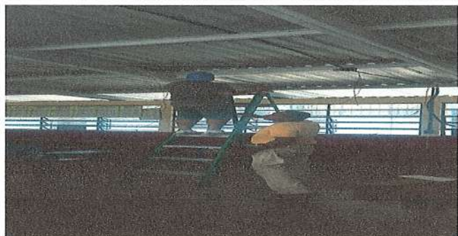
Foto 13: SUSTITUCIÓN DE LAMPARAS POR LAMPARAS TIPO LED CONTRA POLVO Y HUMEDAD, EN 4 EN MÓDULO 1, 23 EN MODULO 2 Y 23 EN MÓDULO 3
