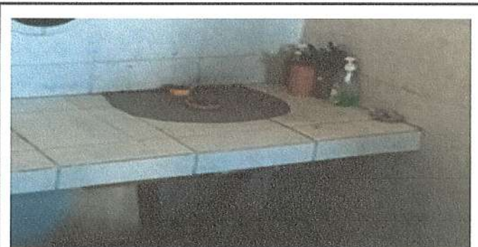
Foto 36: SUSTITUCIÓN DE DOS LAVAMANOS EN BAÑO MÓDULO 1 INCLUYE ACCESORIOS
