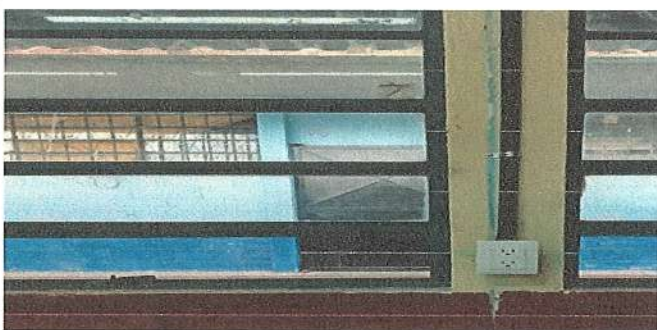
Foto 29: SUSTITUCIÓN DE CABLEADO ELECTRICO, INCLUYE DUCTO, CABLE ELÉCTRICO, CAJAS OCTAGONALES Y CAJAS RECTANGULARES, ABRAZADERA, TORNILLOS EN SALONES Y CORREDORES DE MÓDULO 2
