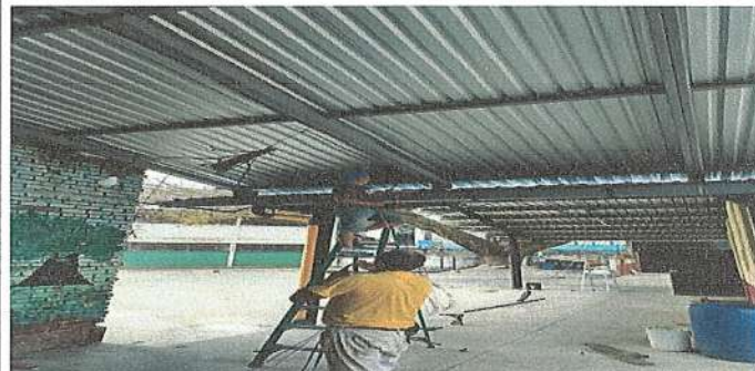
Foto 18: SUSTITUCIÓN DE LAMPARAS POR LAMPARAS TIPO LED CONTRA POLVO Y HUMEDAD, EN 4 EN MÓDULO 1, 23 EN MODULO 2 Y 23 EN MÓDULO 3
