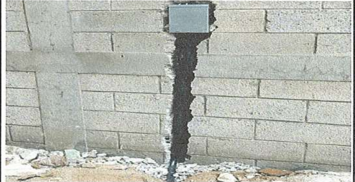
Foto 32: INSTALACION DE ACOMETIDA ELÉCTRICA INCLUYE ACCESORIOS Y CABLEADO DESDE CAJA PRINCIPAL A CAJA DE FLIPONES
