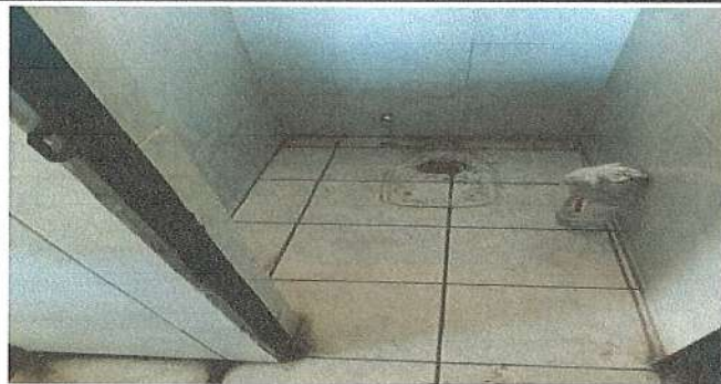
Foto 33: DESISNTALACIÓN E INSTALACION DE 3 SANITARIOS BAÑO MÓDULO 1
