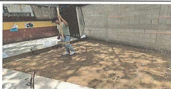
Foto 12: SUSTITUCIÓN Y FUNDICIÓN DE PISO DE CONCRETO CON 15 CMS DE ESPESOR INCLUYE ELECTROMALLA EN PATIO DELANTERO DE LA ESCUELA FRENTE A MÓDULO 1
