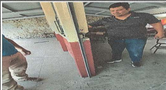
Foto 2: SUSTITUCIÓN DE CHAPA EN BODEGA MÓDULO 3
