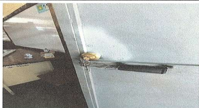
Foto 3: SUSTITUCIÓN DE CHAPA EN BODEGA MÓDULO 2
