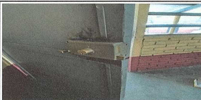
Foto 6: INSTALACIÓN DE CHAPA SALÓN MÓDULO 2
