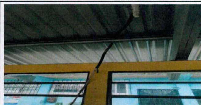
Foto 30: SUSTITUCIÓN DE CABLEADO ELECTRICO, INCLUYE DUCTO, CABLE ELÉCTRICO, CAJAS OCTAGONALES Y CAJAS RECTANGULARES, ABRAZADERA, TORNILLOS EN SALONES Y CORREDORES DE MÓDULO 2
