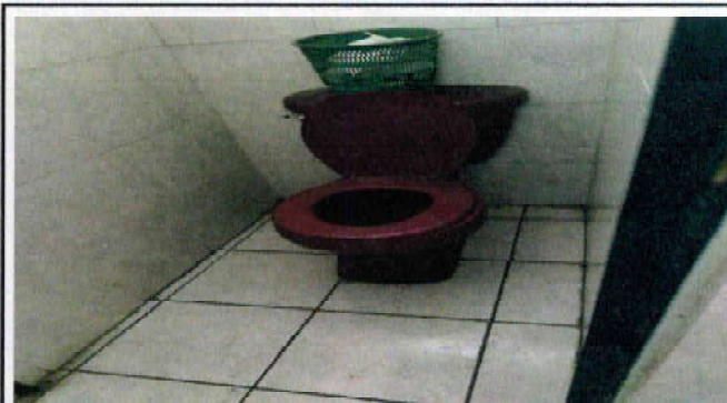
Foto 34: DESISNSTALACIÓN E INSTALACION DE 3 SANITARIOS BAÑO MÓDULO 1
