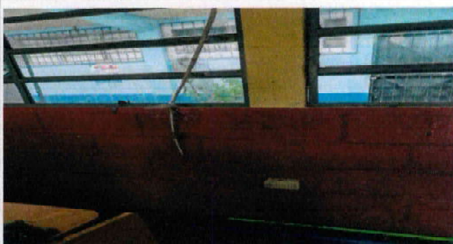
Foto 22: SUSTITUCIÓN DE TOMACORRIENTES DOBLES SALON MODULO 2
