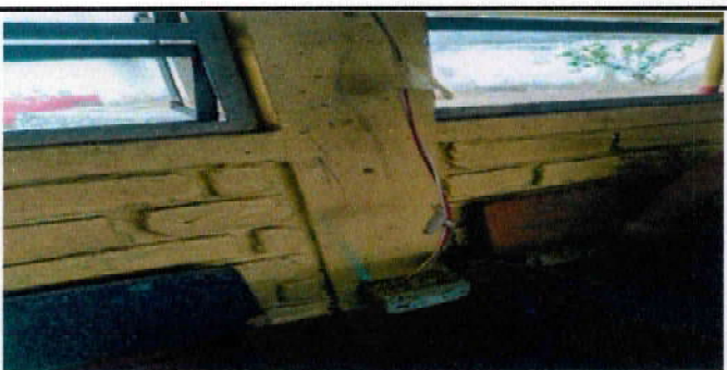
Foto 23: SUSTITUCIÓN DE TOMACORRIENTES DOBLES SALON MODULO 3
