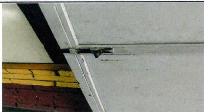
Foto1: INSTALACIÓN DE CHAPA EN MÓDULO 2
