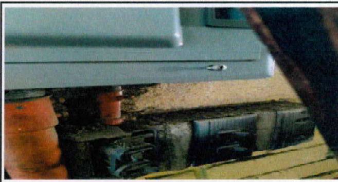
Foto 26: INSTALACIÓN DE 3 TABLEROS ELÉCTRICOS CON SUS ACCESORIOS
