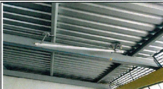
Foto13: SUSTITUCIÓN DE LAMPARAS POR LAMPARAS TIPO LED CONTRA POLVO Y HUMEDAD, EN 4 EN MÓDULO 1, 23 EN MODULO 2 Y 23 EN MÓDULO 3
