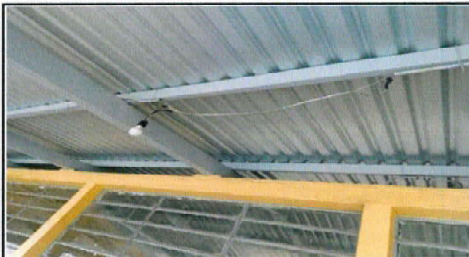
Foto 16: SUSTITUCIÓN DE LAMPARAS POR LAMPARAS TIPO LED CONTRA POLVO Y HUMEDAD, EN 4 EN MÓDULO 1, 23 EN MODULO 2 Y 23 EN MÓDULO 3
