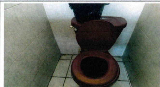
Foto 33: DESISNSTALACIÓN E INSTALACION DE 3 SANITARIOS BAÑO MÓDULO 1
