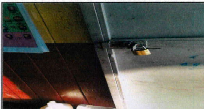
Foto 6: INSTALACIÓN DE CHAPA SALÓN MÓDULO 2
