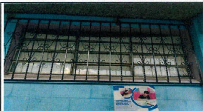
Foto7: SUSTITUCIÓN DE ESTRUCTURA DE METAL DE VENTANA POR VENTANA PVC BLANCO EN MÓDULO 4 PRIMER NIVEL
