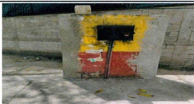
Foto 25: INSTALACIÓN DE 3 TABLEROS ELÉCTRICOS CON SUS ACCESORIOS
