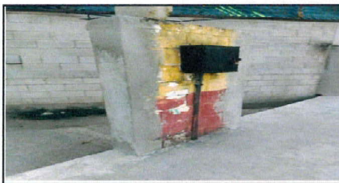
Foto 11: SUSTITUCIÓN Y FUNDICIÓN DE PISO DE CONCRETO CON 15 CMS DE ESPESOR INCLUYE ELECTROMALLA EN PATIO DELANTERO DE LA ESCUELA FRENTE A MÓDULO 1
