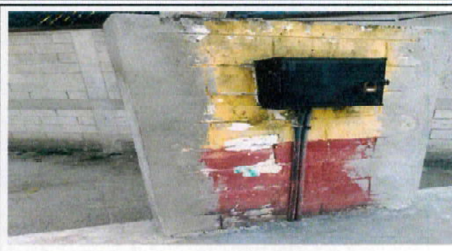
Foto 32: INSTALACION DE ACOMETIDA ELÉCTRICA INCLUYE ACCESORIOS Y CABLEADO DESDE CAJA PRINCIPAL A CAJA DE FLIPONES
