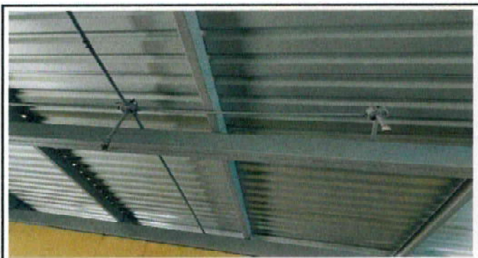
Foto 15: SUSTITUCIÓN DE LAMPARAS POR LAMPARAS TIPO LED CONTRA POLVO Y HUMEDAD, EN 4 EN MÓDULO 1, 23 EN MODULO 2 Y 23 EN MÓDULO 3
