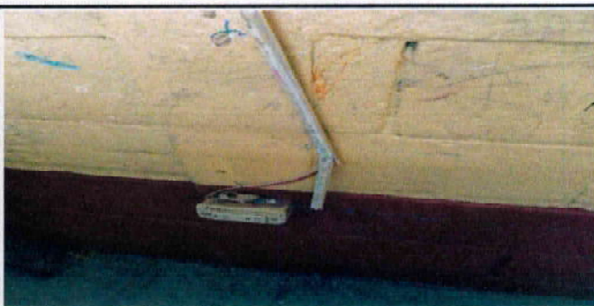
Foto 24: SUSTITUCIÓN DE TOMACORRIENTES DOBLES SALON MODULO 2
