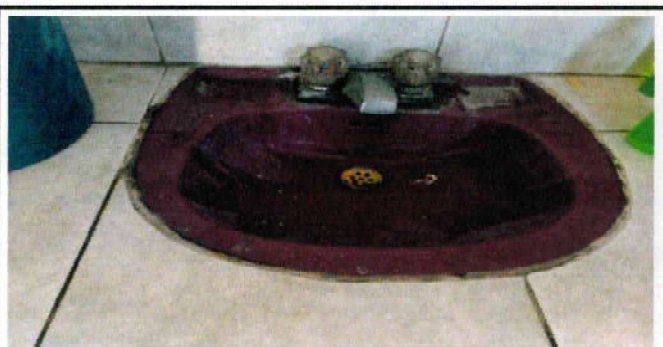
Foto 35: SUSTITUCIÓN DE DOS LAVAMANOS EN BAÑO MÓDULO 1 INCLUYE ACCESORIOS
