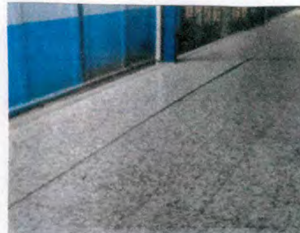
Foto 4: SUSTITUCIÓN DE PISO DE GRANITO EN PASILLOS, INCLUYE LEVANTADO DE PISO, EXCAVACIÓN, CORTE DE RAÍZ, RELLENO, COMPACTACIÓN NIVELACIÓN Y COLOCACIÓN DE PISO NUEVO
