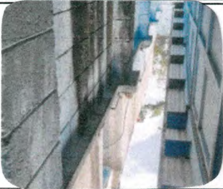
Foto1: PINTURA EN MURO INTERIOR: APLICACIÓN DE PINTURA ANTIHONGO E IMPERMIABILIZACIÓN DE PARED DE MURO INTERNO DAÑADA POR HUMEDAD 100 M2
