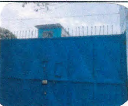
Foto 6: SUSTITUCIÓN DE PORTÓN DE METAL: ELABORACIÓN A 2 HOJAS, CON TUBO CUADRADO DE 1 1/2 Y CHAPA 16 LEGÍTIMO Y LAMINA DE 1/8, COLOCACIÓN DE PASADORES ARGOLLAS PARA CANDADOS Y CAMBIO DE CHAPA, APLICACIÓN DE ANTICORROSIVO Y PINTURA DE 3.98*2.50 M
