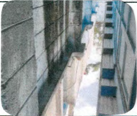
Foto1: PINTURA EN MURO INTERIOR: APLICACIÓN DE PINTURA ANTIHONGO E IMPERMEABILIZACIÓN DE PARED DE MURO INTERNO DAÑADA POR HUMEDAD 100 M2
