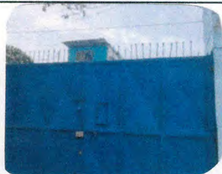
Foto 6: SUSTITUCIÓN DE PORTÓN DE METAL: ELABORACIÓN A 2 HOJAS, CON TUBO CUADRADO DE 1 1/2 Y CHAPA 16 LEGÍTIMO Y LAMINA DE 1/8, COLOCACIÓN DE PASADORES ARGOLLAS PARA CANDADOS Y CAMBIO DE CHAPA, APLICACIÓN DE ANTICORROSIVO Y PINTURA DE 3.98*2.50 M
