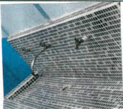
Foto 5: SUSTITUCIÓN DE GRIFOS
