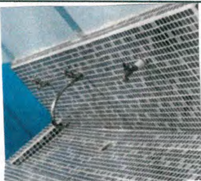
Foto 5: SUSTITUCIÓN DE GRIFOS
