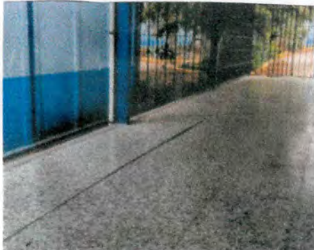
Foto 3: CEPILLADO, APLICACIÓN DE PINTURA, SOLDADO DE PIEZAS FALTANTES, REPARACIÓN DE PUERTA DE METAL DE CORREDOR, CEPILLADO Y PINTURA, COLOCACIÓN DE ARMADURA PARA SEGURIDAD, PINTURA CEPILLADO Y COLOCACIÓN DE ESTRUCTURAS PARA SU SOSTENIMIENTO.
