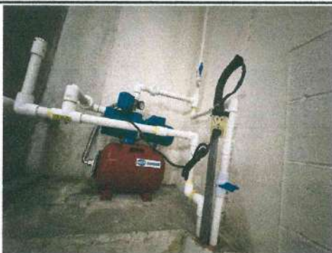
SUSTITUCIÓN DE BOMBA DE AGUA DE 1HP
