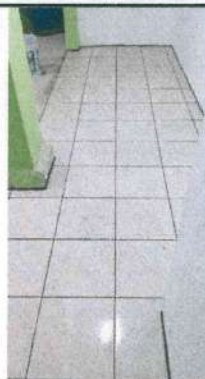
SUSTITUCIÓN DE PISO CERÁMICO
