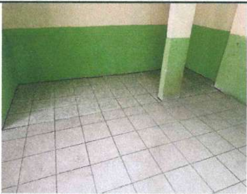
SUSTITUCIÓN DE PISO CERÁMICO
