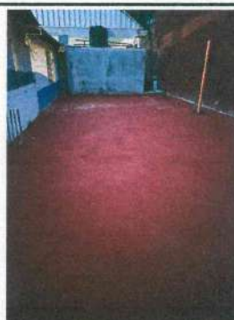
REPARACIÓN DE PAÑUELOS E IMPERMIABILIZACIÓN DE LOSA
