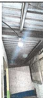
INSTALACIÓN DE FOCOS AHORRADORES
