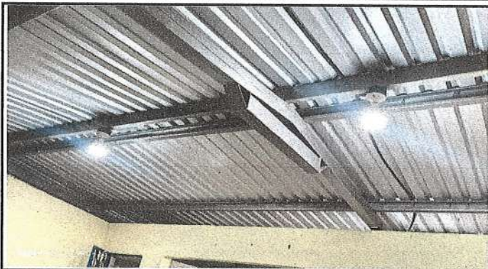
INSTALACIÓN DE FOCOS AHORRADORES
