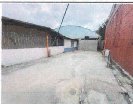
Foto 6: Terraza sin impermeabilizar ni bajadas de agua.
