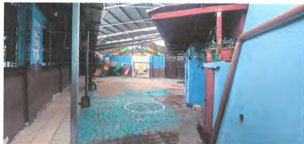
Foto 2: PINTURA DE PATIO
