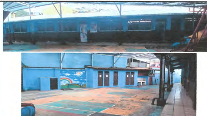
Foto 4: PINTURA DE PATIO
