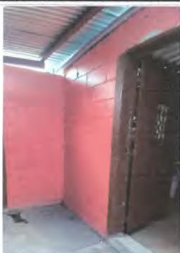
Foto 3: MUROS DE COCINA SIN REPELLO INTERIOR/EXTERIOR
