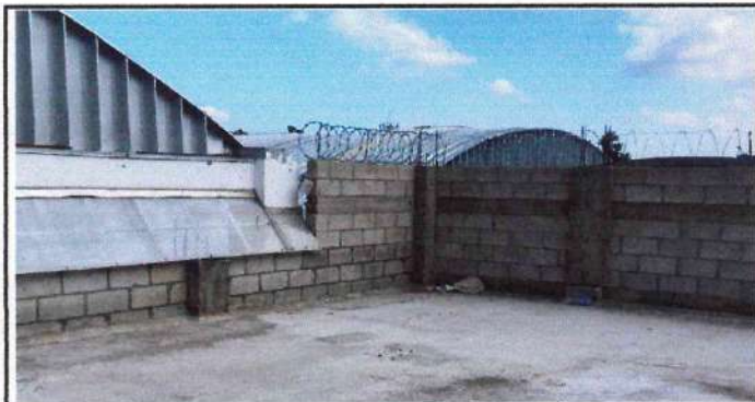
Foto 3: LEVANTADO DE PARED PERIMETRAL.
