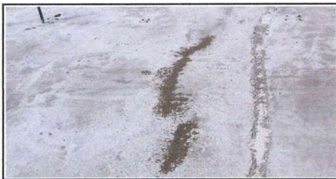
Foto 5: SELLO DE GRIETAS EN LOSA DE SEGUNDO NIVEL.
