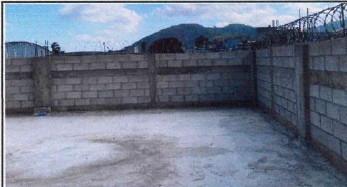
Foto 2: LEVANTADO DE PARED PERIMETRAL.
