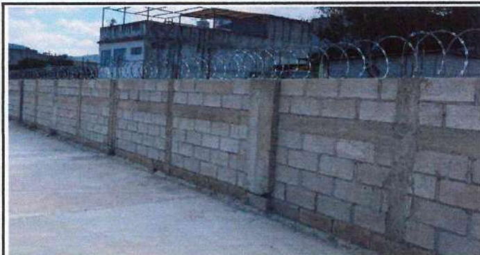
Foto1: LEVANTADO DE PARED PERIMETRAL.
