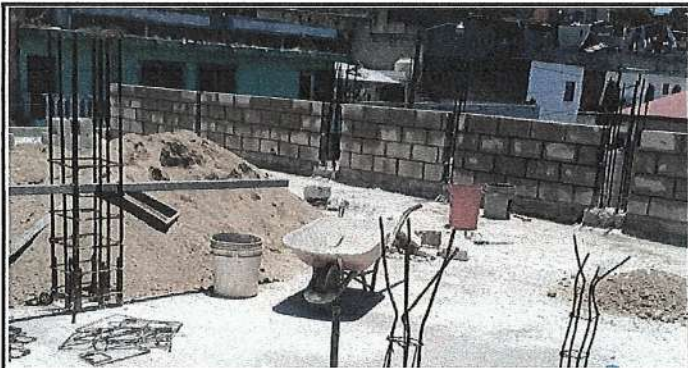
Foto 1: LEVANTADO DE PARED PERIMETRAL.
