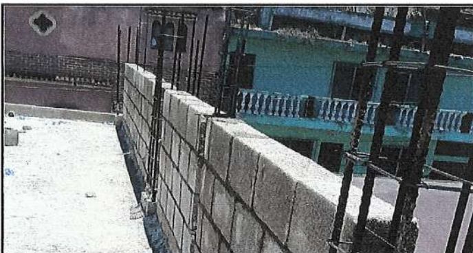
Foto 3: LEVANTADO DE PARED PERIMETRAL.
