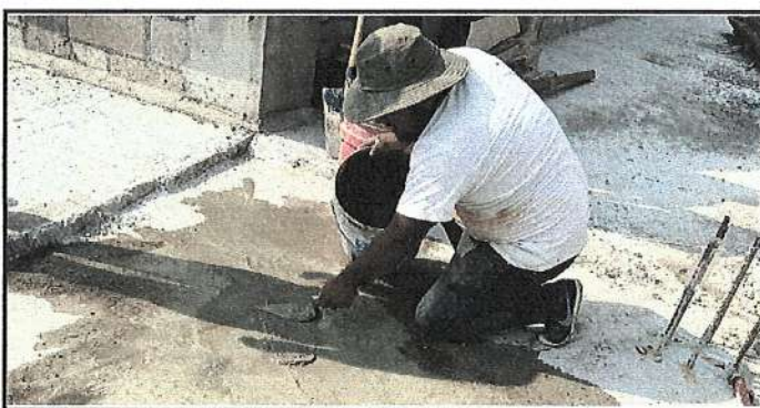
Foto 6: SELLO DE GRIETAS EN LOSA DE SEGUNDO NIVEL.
