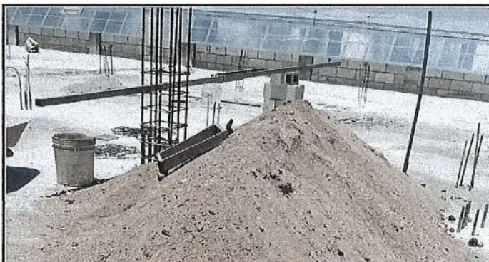
Foto 4: LEVANTADO DE PARED PERIMETRAL.
