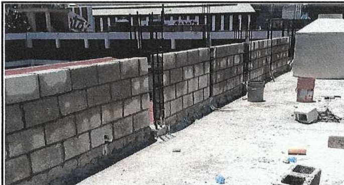
Foto 2: LEVANTADO DE PARED PERIMETRAL.
